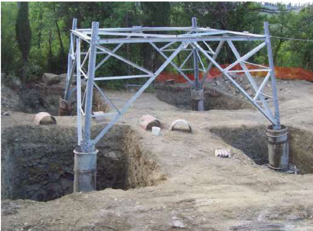
Figura 1 - Realizzazione di fondazioni superficiali tipo CR per un sostegno a traliccio.
