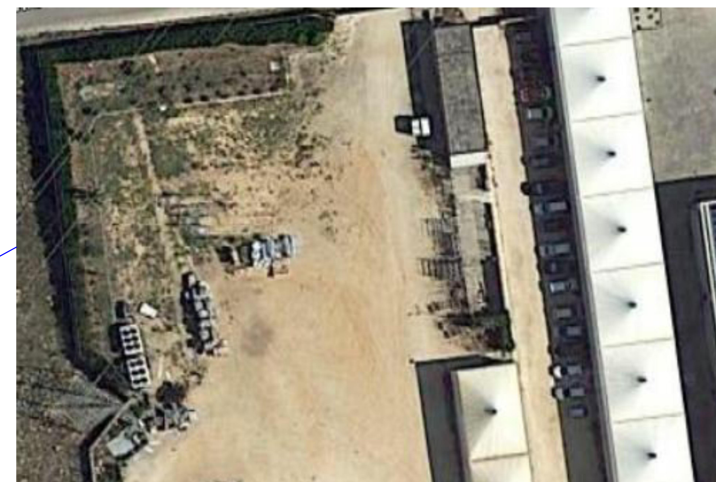
Particolare zona traliccio da rimuovere - Fuori scala
