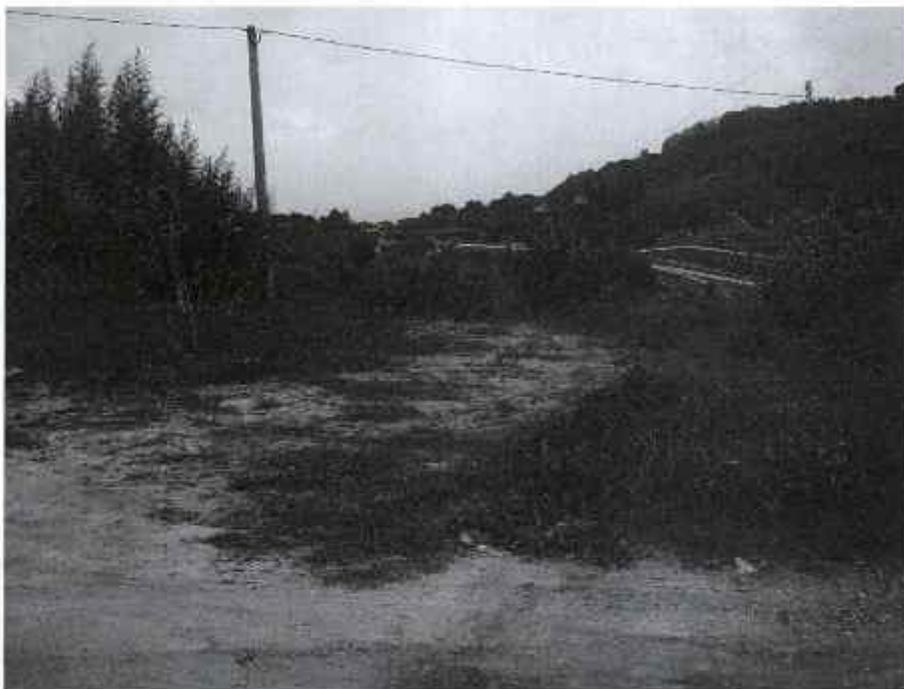
Le precipitazioni non regimate hanno agito su di un substrato riportato e poco inerbito pertanto hanno comportato l'innescarsi di forti processi erosivi localizzati (vedi ripresa sotto riportata).
