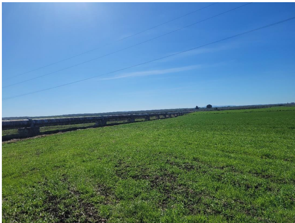
Figura 7 - report fotografico stato di fatto aree di impianto
