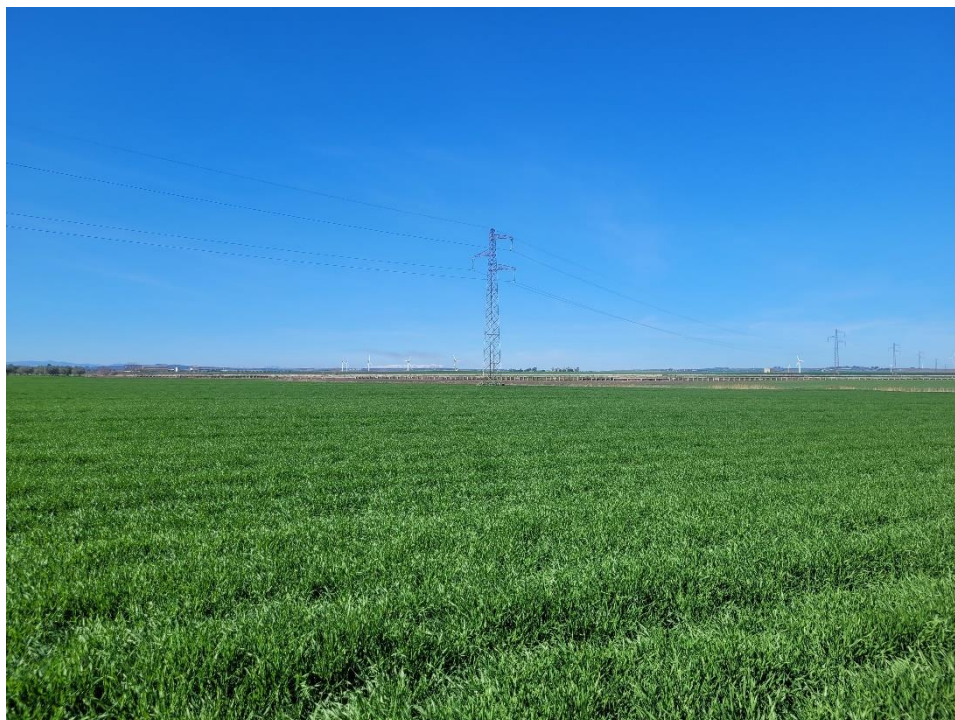
Figura 5 – report fotografico stato di fatto aree di impianto
