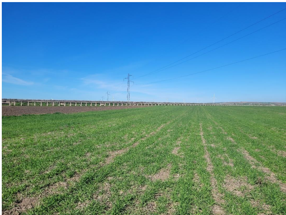
Figura 9 - report fotografico stato di fatto aree di impianto
