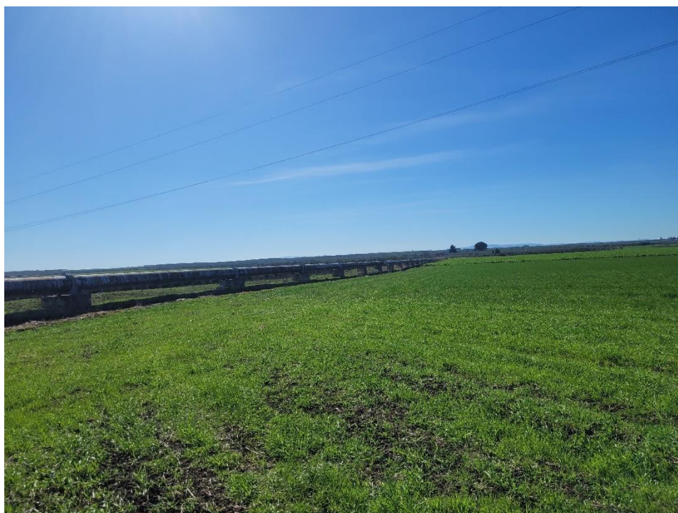
Figura 7 - report fotografico aree di impianto
