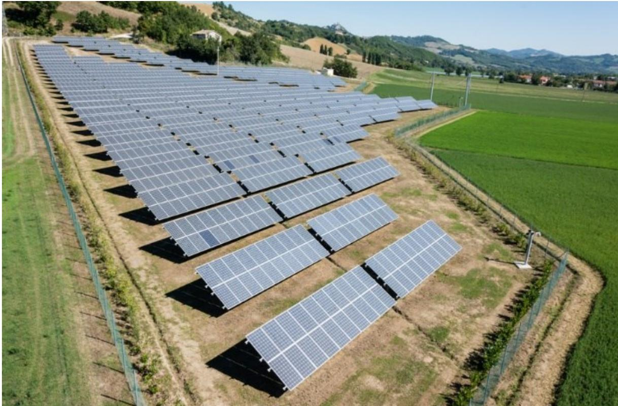
Le strutture sono direttamente ancorate al terreno per mezzo di sistemi di fondazione a secco o per mezzo di zavorre in calcestruzzo prefabbricato.
