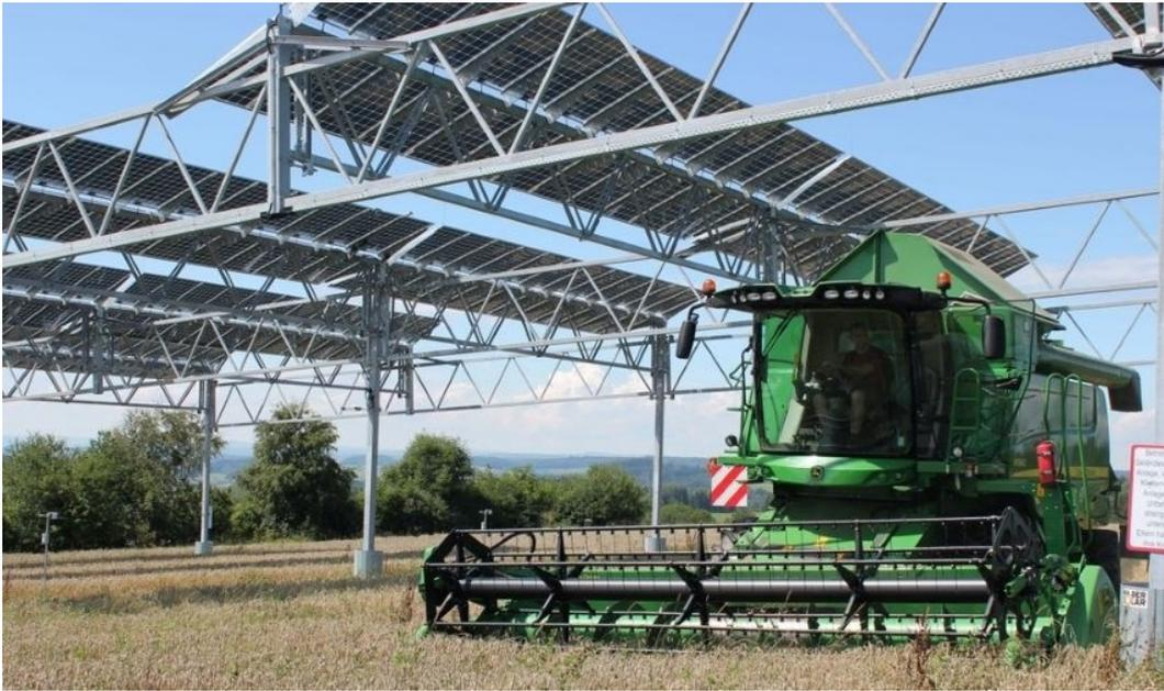
Tale sistema è progettato e realizzato in modo da adottare una configurazione spaziale tale da consentire l'integrazione ottimale fra attività agricola e produzione elettrica e valorizzare il potenziale produttivo di entrambi i sottosistemi.
