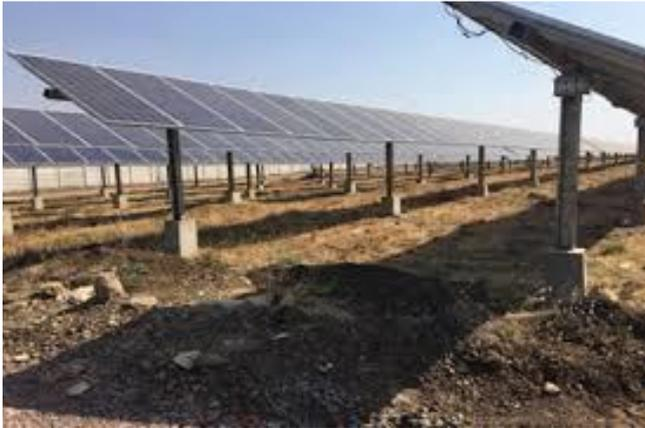
**Predrilled and concrete backfilled.** In questa soluzione il terreno viene perforato e viene poi creato il palo di fondazione con getto di cemento (in figura a sinistra). Si tratta di una soluzione altamente impattante dal punto di vista ambientale, anche nell'ottica della futura dismissione dell'impianto. Per tale motivo **questa soluzione è stata scartata.**
