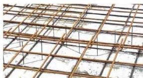
**REALIZZAZIONE DEL PIANO DI APPOGGIO DI UNA VASCA/BASAMENTO CON CALCESTRUZZO DOSATO CON ALMENO 300 KG DI CEMENTO TIPO 325 E CON RESISTENZA SPECIFICA NON INFERIORE A RCK 250 KG./CM2, ARMATO CON DOPPIA RETE ELETTROSALDATA DI DIAMETRO MIN. PARI A 10 MM CON MAGLIA 10X10. H SOLETTA FINITA 200 MM, PERFETTAMENTE LIVELLATA.**
