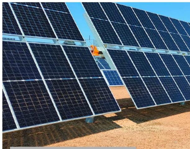
L'altezza dei moduli fotovoltaici misurata da terra fino al bordo inferiore del modulo fotovoltaico alla massima inclinazione tecnicamente raggiungibile varia in funzione dell'angolo massimo di rotazione dei moduli fotovoltaici.
