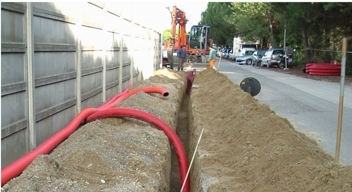
Scavi per una linea elettrica interrata su strada asfaltata
