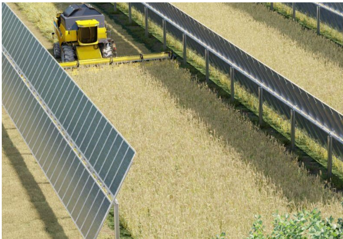
Particolare inseguitore monoassiale
