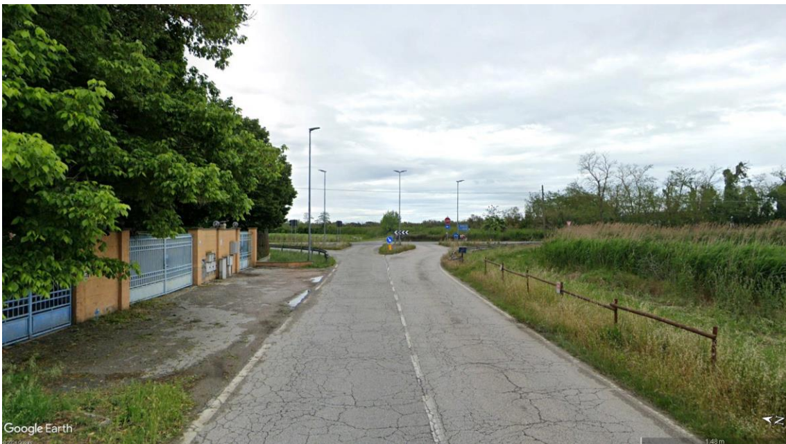
Figura 2-16 – SP. 55 Via Rotta Zambusi direzione Est
