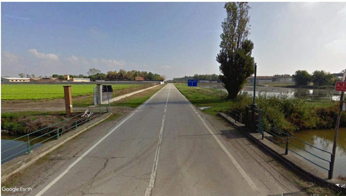
Figura 2-12 – SP. 55 Via Rotta Zambusi direzione Est
