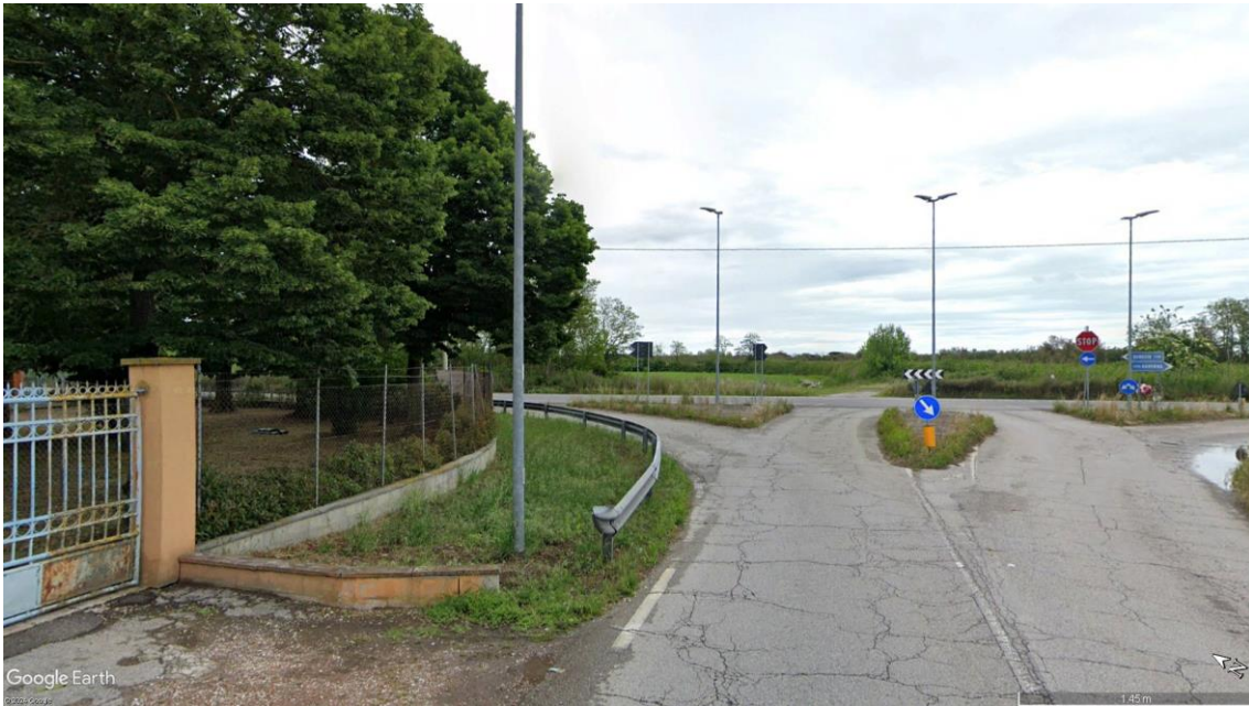
Figura 2-17 – SP. 55 Via Rotta Zambusi direzione Est
