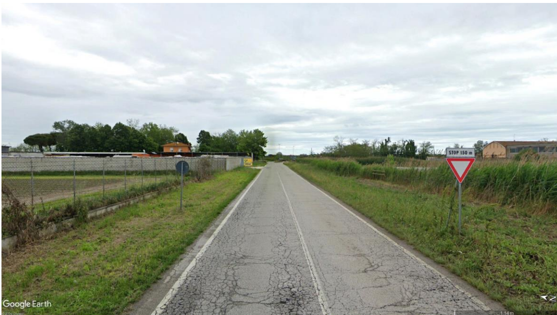
Figura 2-14 – SP. 55 Via Rotta Zambusi direzione Est
