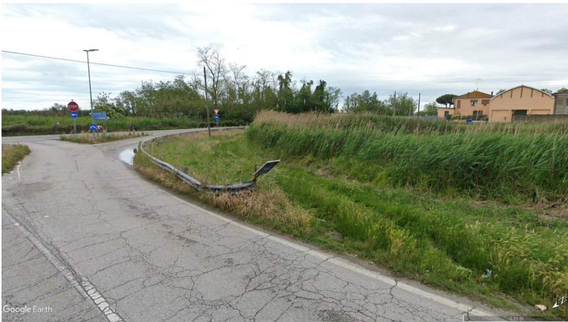
Figura 2-18 – SP. 55 Via Rotta Zambusi direzione Est
