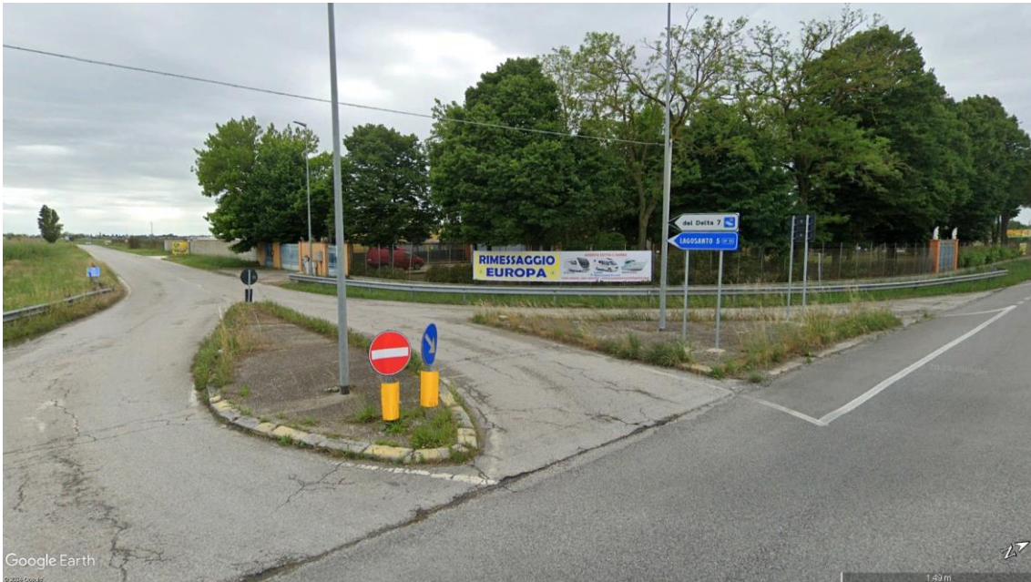
Fig. 13: SS. 309 Direzione Sud
