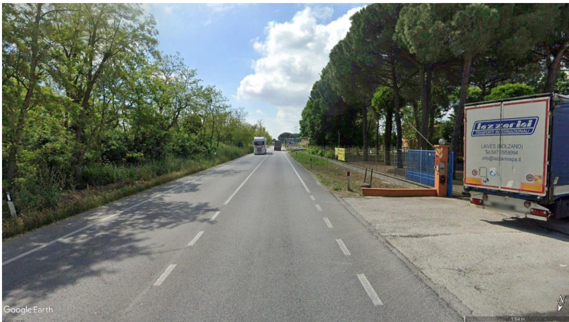
Fig. 10: SS. 309 Direzione Sud
