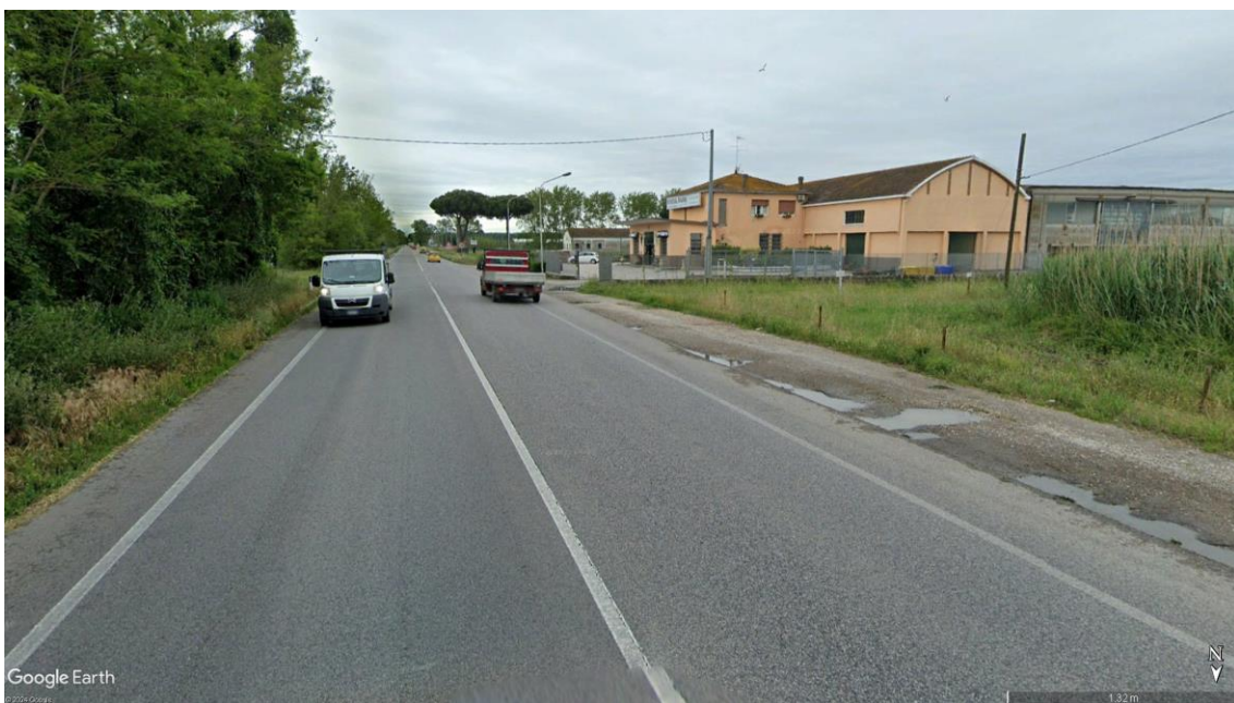
Fig. 14: SS. 309 Direzione Sud
