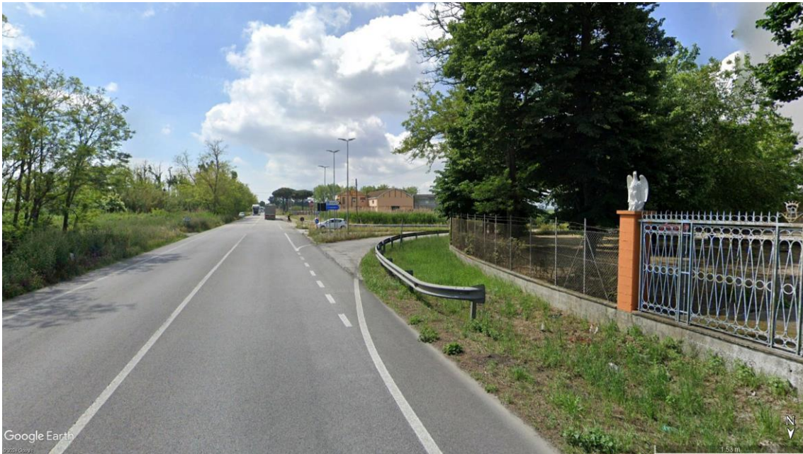
Fig. 11: SS. 309 Direzione Sud
