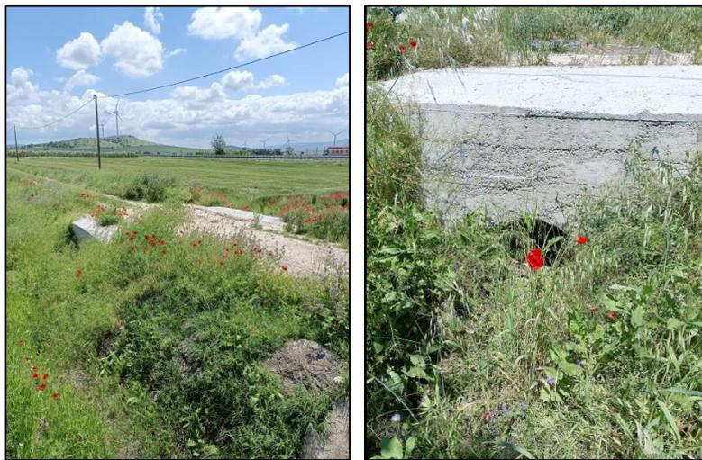
Per il passaggio sull'alveo minuto si procederà a progettare un attraversamento tombato con una tubazione circolare di DN1000,
