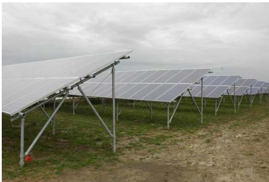
Figura 23: Esempio impianto a strutture fisse
