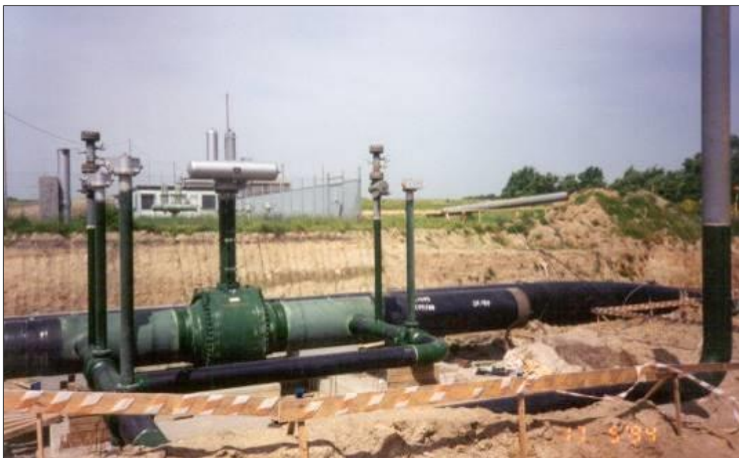
Foto 2.2-8: Esempio della realizzazione di un Punto di Intercettazione di Linea (PIL)
