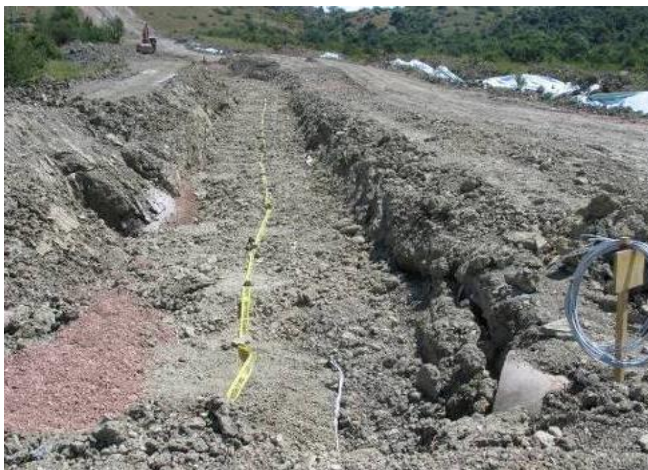
Foto 2.2-5: Rinterro della condotta
