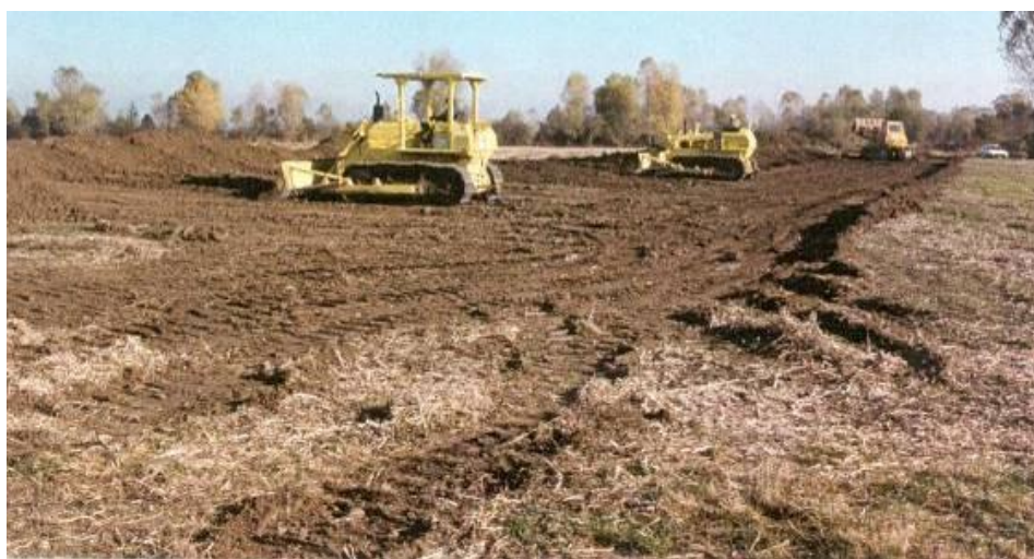
Foto 2.2-2: Apertura dell'area di passaggio (scotico)
