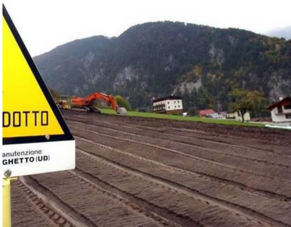
Foto 2.2-6: Ridistribuzione dello strato humico superficiale
