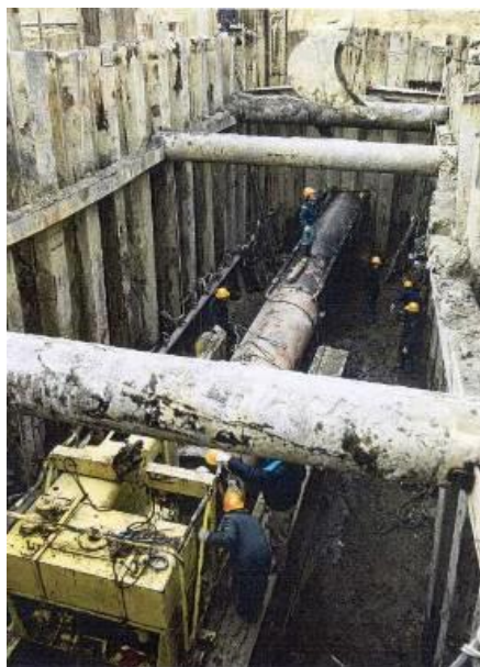
Foto 2.2-7: Trivellazione con spingitubo
