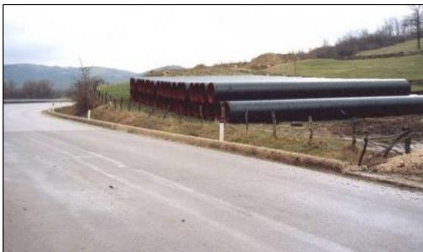
Foto 2.2-1: Piazzola di accatastamento tubazioni
