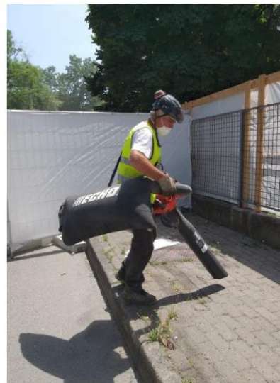
Figura 5 - Sistema di abbattimento delle polveri "DustBuster" (sx), Operazione di aspirazione puntuale del polistirolo a terra (dx).
