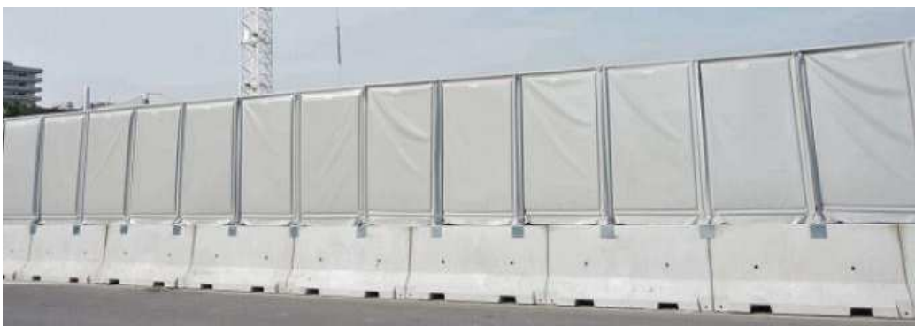
Fig.4 – new jersey in cemento armato alla base e pannello tipo Acustiko Silte
