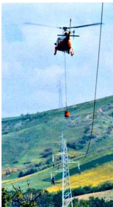
Foto n° 3.1: Elicottero impegnato nella fase di tesatura della fune di nylon: le maestranze collaborano sui tralicci.
