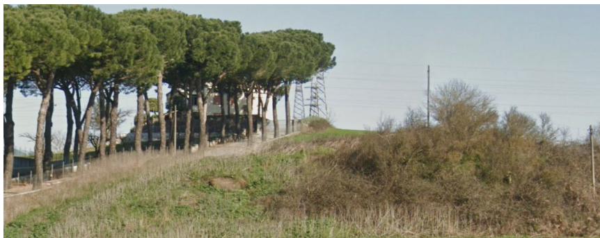
Manufatti n°5-6-7-8-9 e Sostegno n° 13
