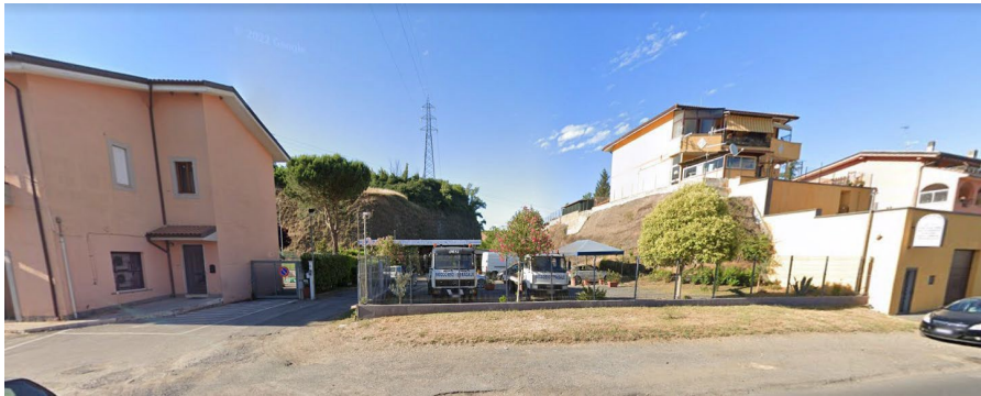
Manufatto n°4 sulla dx e Sostegno n°3
