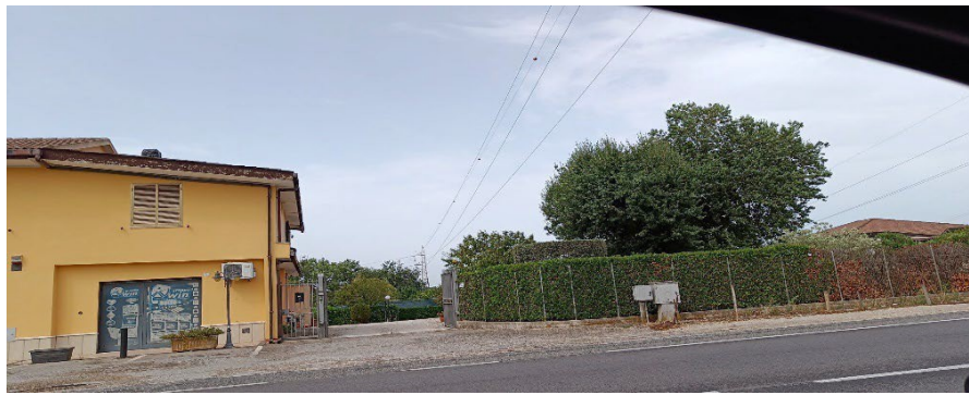
Figura 12: Manufatto n° 20 a dx con Sostegno n° 35
