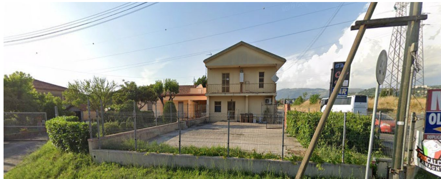
Figura 14: Manufatti n° 17-18 sotto tratta Sostegni n° 35-36
