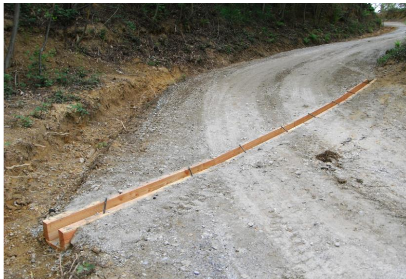
Esempio di realizzazione tratto dal sito della segheria Valle Sacra
