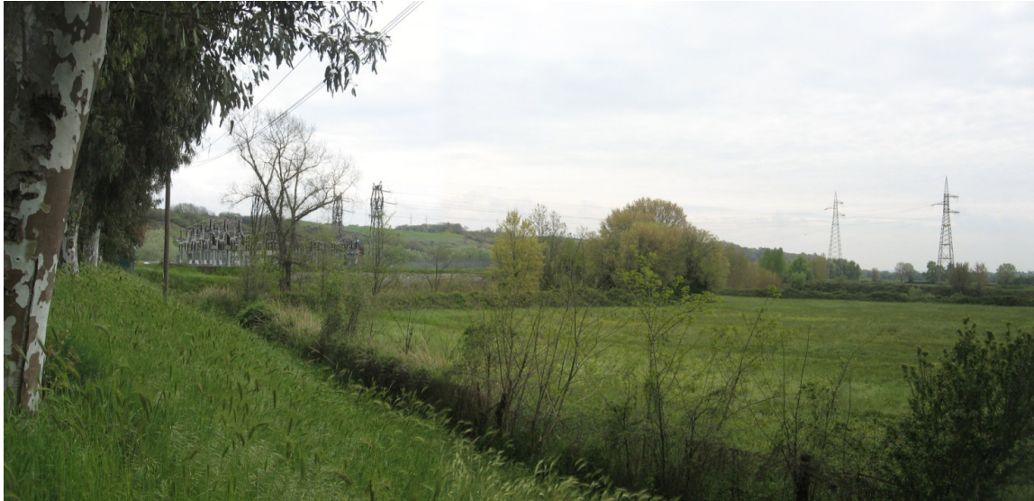
Foto 1: La Centrale Enel di Nazzano.
