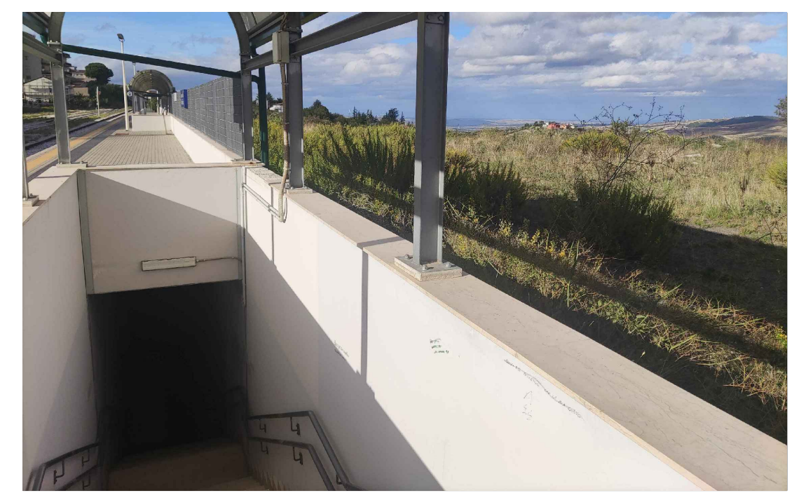
FOTO 1 - AREA TECNICA AT1-34
