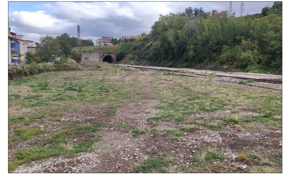
FOTO 1 - AREA TECNICA AT1-33
