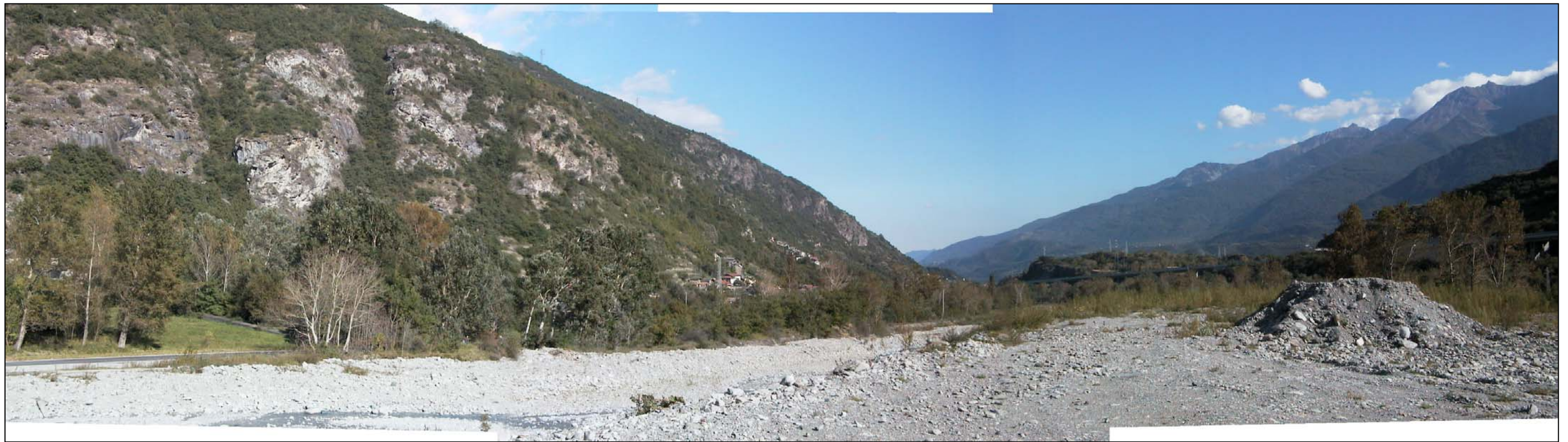
Vista verso est e sud dai viadotti Val Cenischia: sulla sinistra l'imbocco ovest del tunnel di Bussoleno, sulla destra il forte della Brunetta e la Val di Susa
