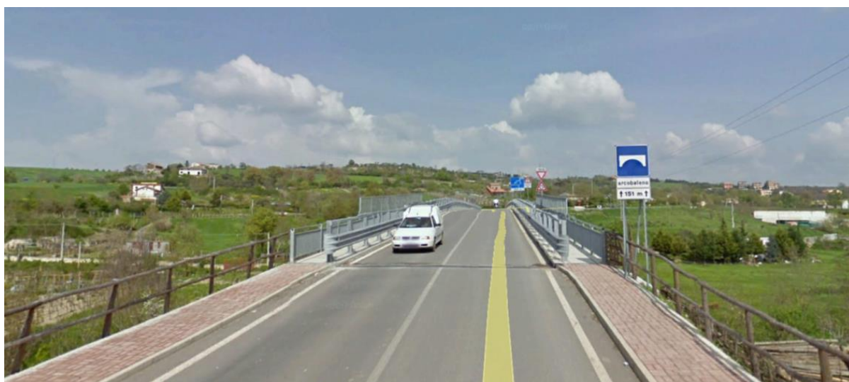
Vista della viabilità d'accesso (cavalcaferrovia)
