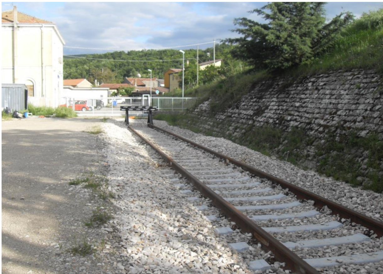
Foto 1 – vista dell'accesso al cantiere
