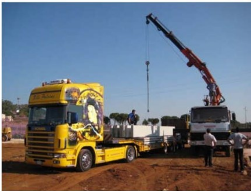
Figura 25 | Attività di scarico cabina di campo
