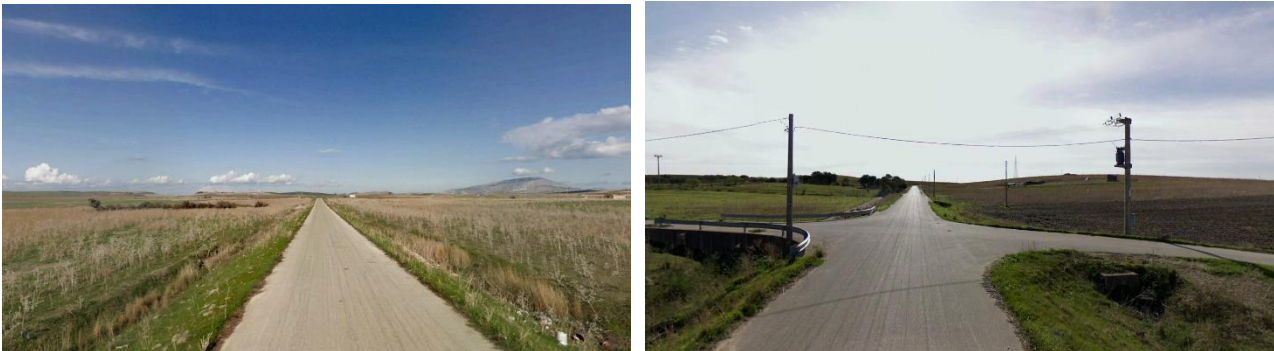
Figura 10 stato di fatto della RT 628 – Intersezione del cavidotto con la viabilità storica punto A rispettivamente in direzione Nord e in direzione Sud
