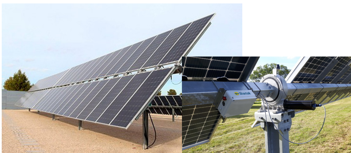
Fig.19- Sistema dei tracker porta moduli
