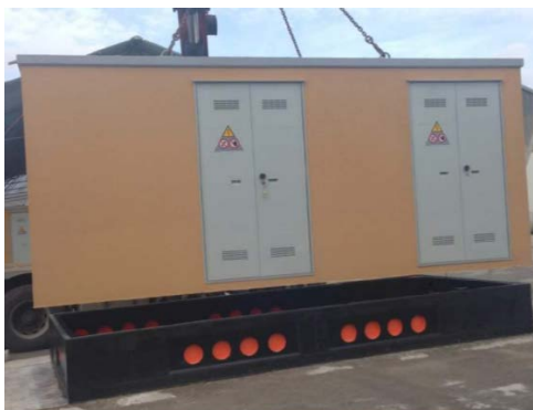
Fig.7- cabina tipo prefabbricata
