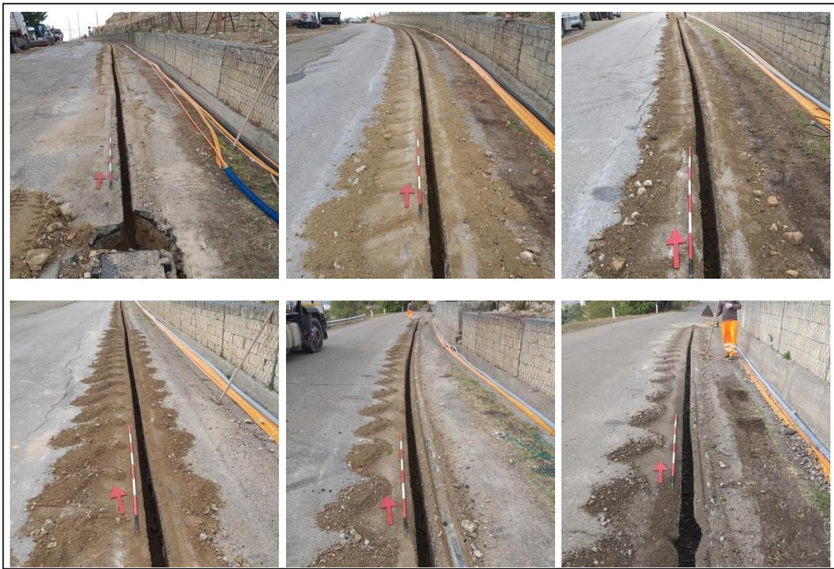
**Fig. 11:** Open Fiber 2019-Esempi di lavorazioni e stratigrafia: minitrincee
