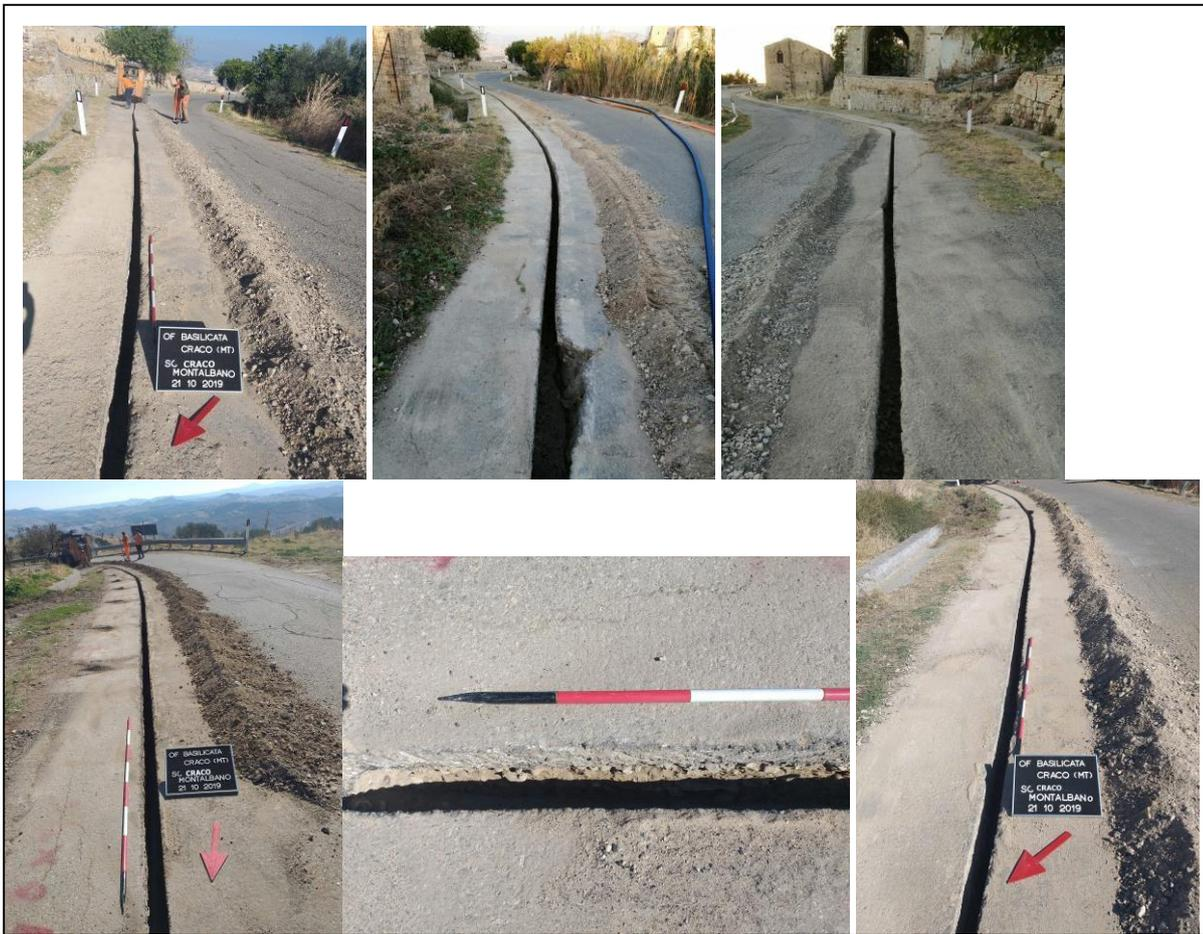
Fig. 13: Open Fiber 2019- Esempi di lavorazioni e stratigrafia lungo SC Craco-Montalbano: minitrincee
