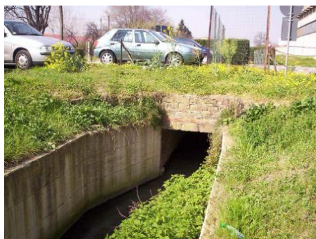
Figura 4-2 – Tombino di accesso ex stabilimento "Sun Chemicals"
