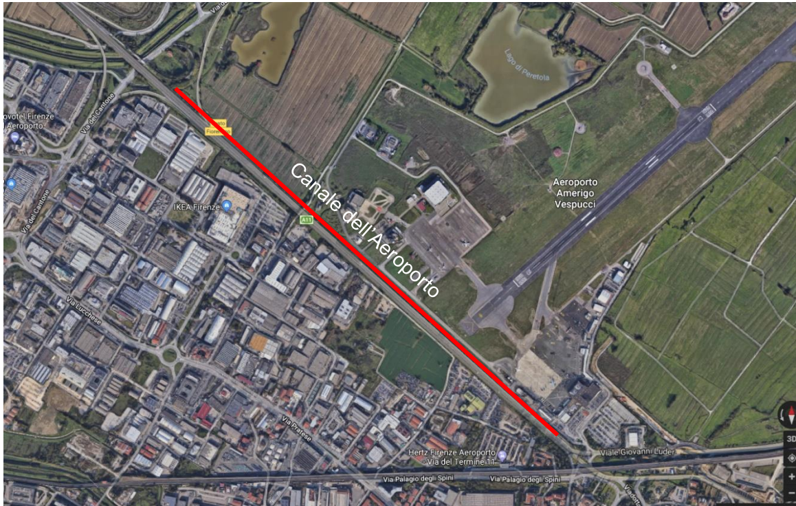
Figura 2-10 - Vista aerea del Canale dell'Aeroporto
