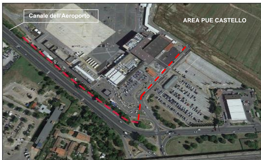
Figura 2-11 Vista aerea del tratto iniziale intubato.
