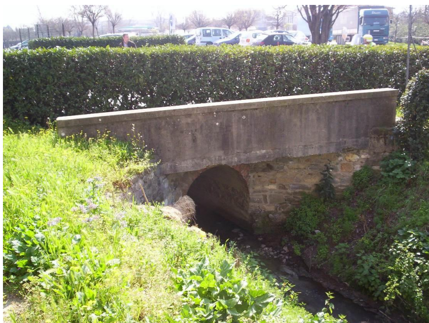
Figura 2-7 : Attraversamento n° 2. Accesso SUN CHEMICAL. Tombino visto da monte e da valle.
