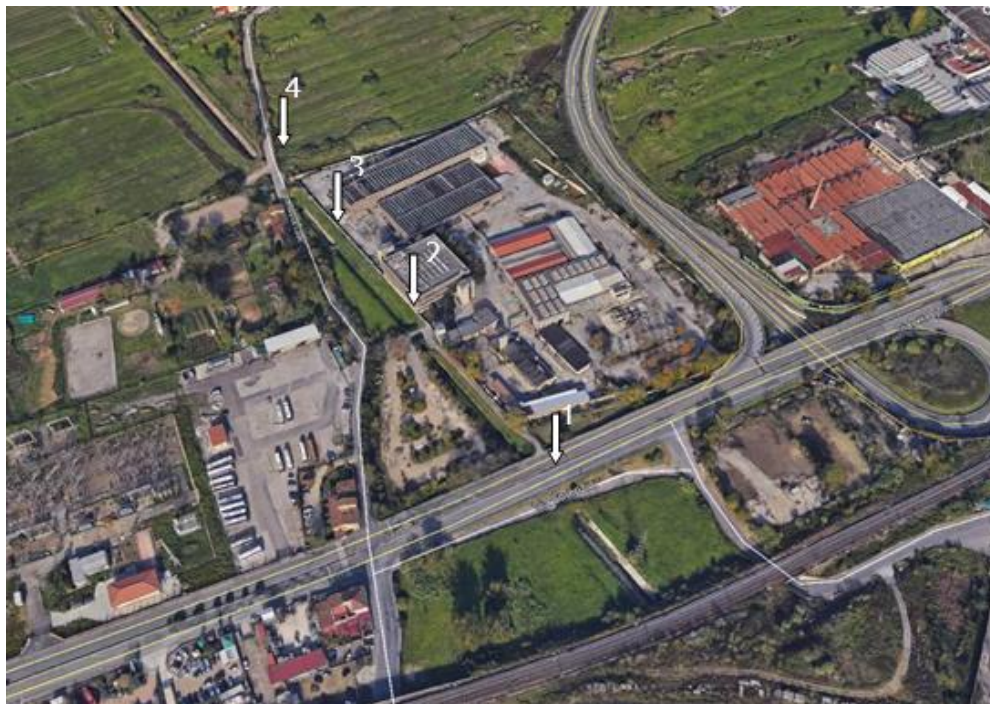
Figura 2-2 Canale di Cinta Orientale - Stato Attuale – ortofoto con ubicazione dei primi 4 tombini e profili TR 200 anni e durate 1,3,6,18,24,36 ore
