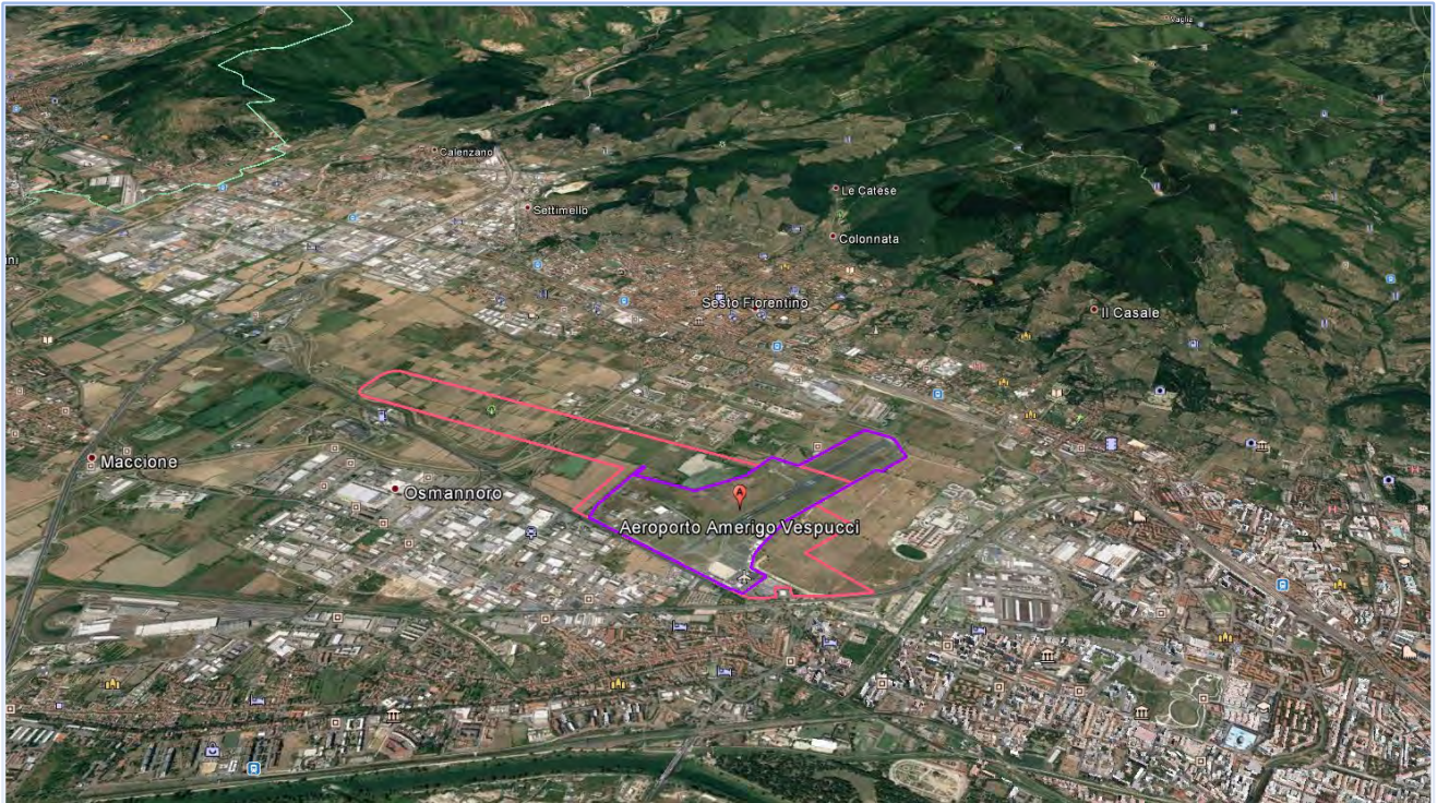
Figura 2: Localizzazione dell'Aeroporto "Amerigo Vespucci" in vista tridimensionale (Fonte Google Earth) – in rosa la porzione in progetto, in viola la porzione attuale.
