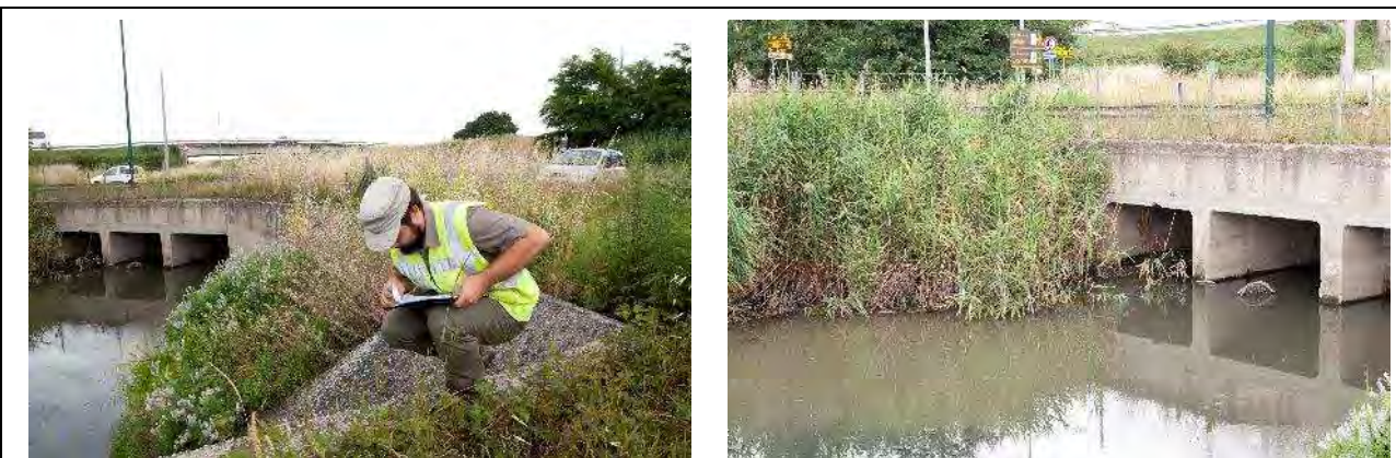
Vegetazione perifluviale (domande 2-4). A sinistra: dettaglio della conformazione spondale del tratto considerato: si nota l'impermeabilizzazione totale delle sponde. A destra: formazione relitta di Phragmites australis presente in fascia perifluviale primaria: considerandone la natura e la limitata estensione, si è scelto di procedere al rilievo unicamente della fascia perifluviale secondaria.
