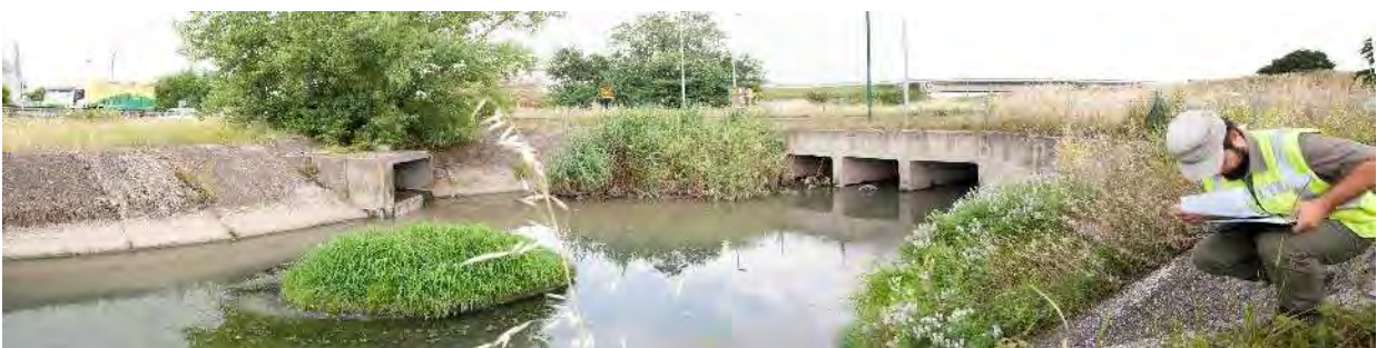
Sito ASUP-8 – Canale Colatore Sinistro, ripreso dall'argine E, prima dello scolare sotto via del Cantone (in secondo piano).
