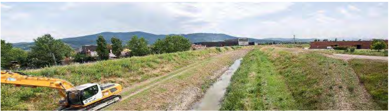
Fosso Reale a monte del ponte di Dogaia: in secondo piano sono visibili l'impianto di trattamento R.U. di Case Passerini (al centro) e la zona commerciale dell'Isolotto (a destra). Nel tratto in esame le sponde sono periodicamente sfalciate e rimodellate con mezzi meccanici.
