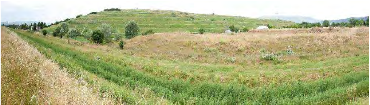
Canale Colatore Destro nel tratto sotteso alla discarica di Case Passerini (al centro, in secondo piano).
