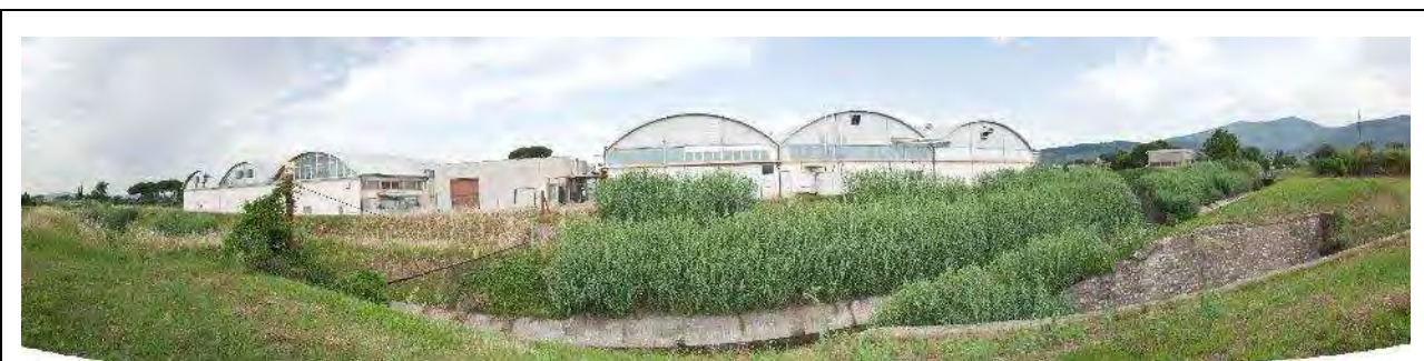
Stato del territorio circostante (domanda 1): Panoramica verso monte: è visibile il tessuto urbano che caratterizza l'area, sviluppato in modo continuo (sponda sinistra, in primo piano nell'immagine) o discontinuo (sponda destra, in secondo piano nell'immagine).
