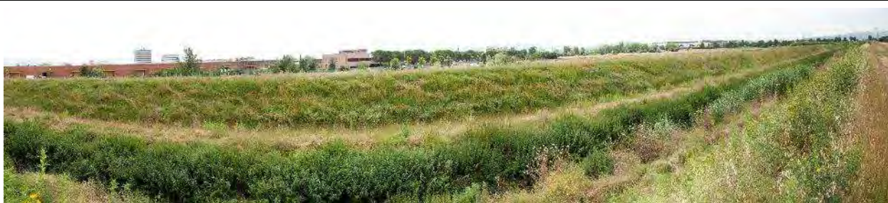
Sito ASUP-10 – Panoramica del Canale Colatore Destro nella sezione rilevata: sullo sfondo sono visibili gli edifici della Motorizzazione Centrale e gli annessi commerciali della zona dell'Osmannoro.
