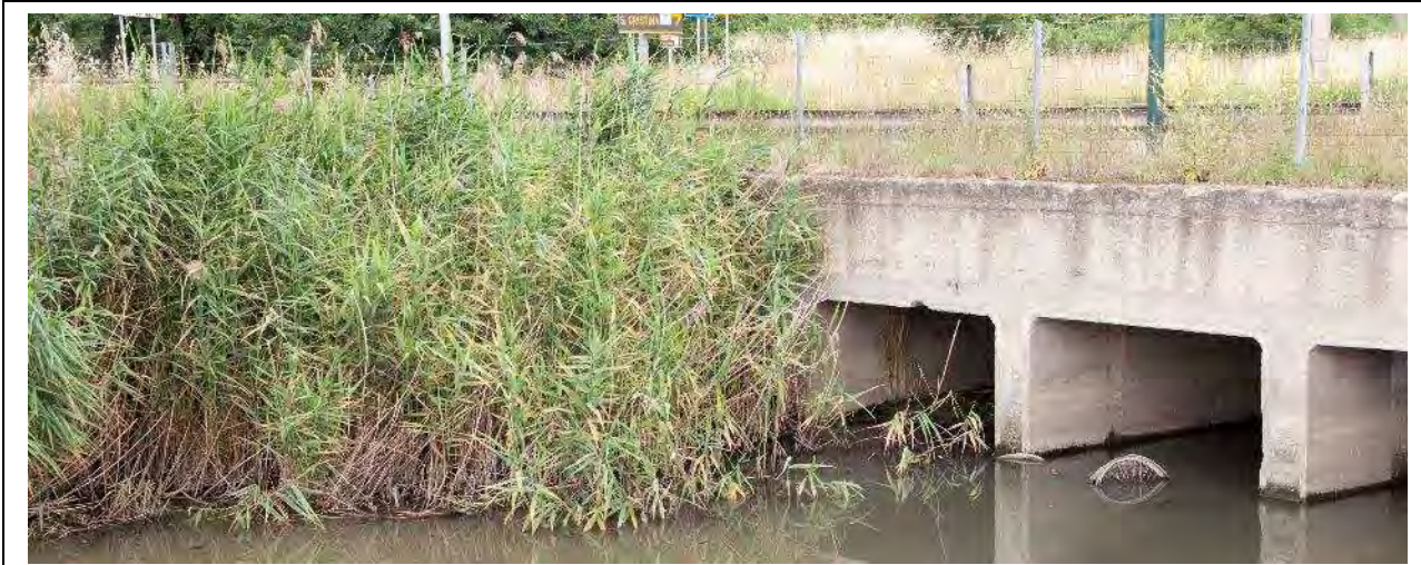
Sito ASUP-8/1 – Panoramica del sito di rilievo verso valle; si notano i resti della piccola formazione a Phragmites australis in alveo (presso l'argine sinistro), nonché la totale artificialità della sezione considerata. Sono visibili alcuni rifiuti al di sotto dello scatolare che attraversa via del Cantone.
