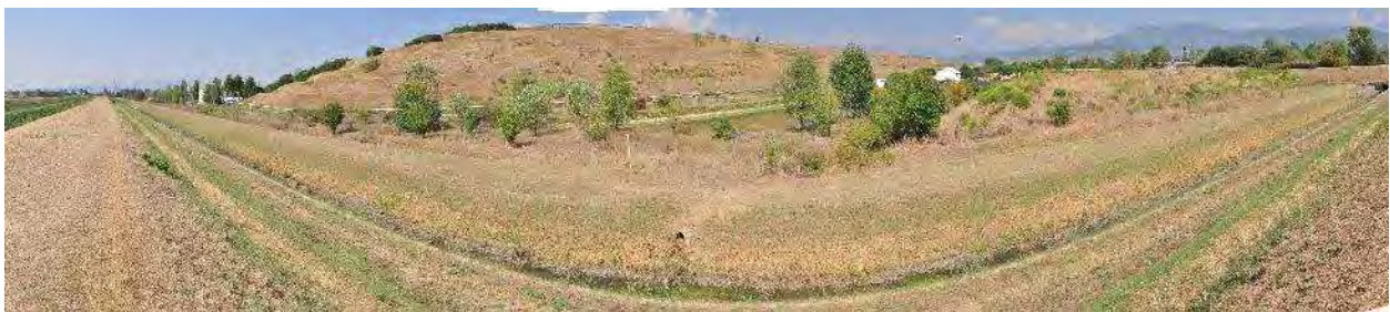
Sito ASUP-10 – Panoramica del Canale Colatore Destro nella sezione rilevata: sullo sfondo è visibile la discarica in via di rinaturalizzazione.
