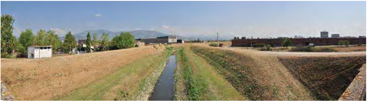
Fosso Reale a monte del ponte di Dogaia: in secondo piano sono visibili l'impianto di trattamento R.U. di Case Passerini (al centro) e la zona commerciale dell'Isolotto (a destra). Nel tratto in esame le sponde appaiono sfalciate con mezzi meccanici.
