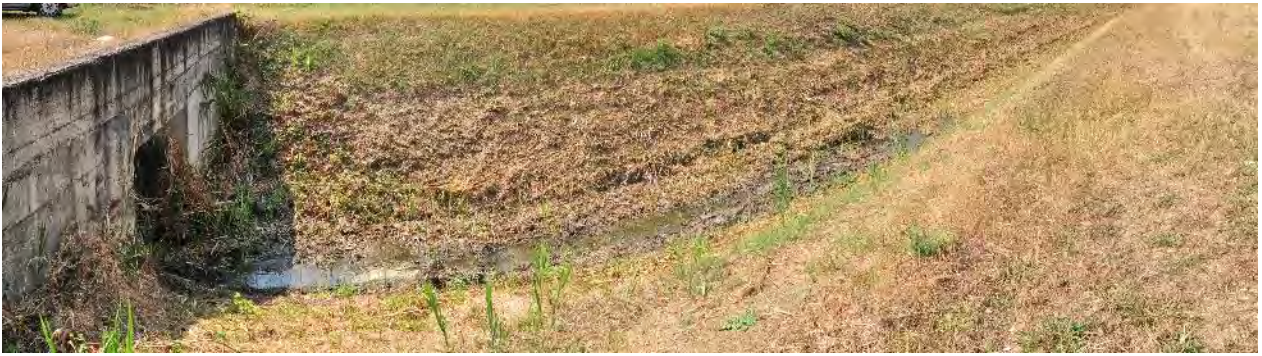
Stato dell'alveo (domande 5-9). Panoramica del tratto in esame presso l'inizio del transetto di campionamento: la sezione dell'alveo si presenta relativamente omogenea (artificializzata), con una buona efficienza di esondazione.
