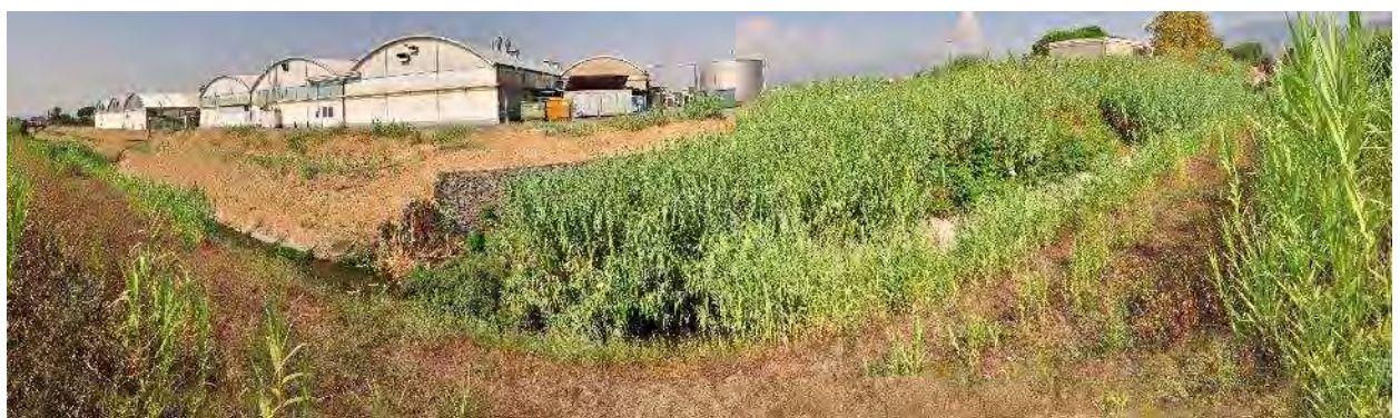
Stato del territorio circostante (domanda 1): Panoramica verso monte: è visibile il tessuto urbano che caratterizza l'area, che assume carattere continuo in sponda sinistra, mentre ha carattere discontinuo lungo la sponda destra (es. gli edifici industriali in secondo piano nell'immagine).
