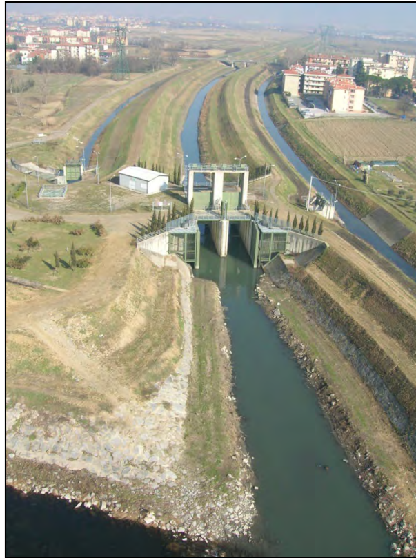
Figura 5: vista delle porte Vinciane- vista da valle.
