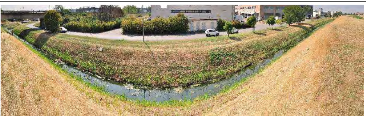
Vegetazione perifluviale (domande 2-4): Formazione non funzionale (erbacee non igrofile) su entrambe le sponde del canale. In alveo si nota un piccolo popolamento ad elofite in fase di ripresa dopo un recente sfalcio meccanico. In secondo piano, gli edifici commerciali dell’Osmannoro.
