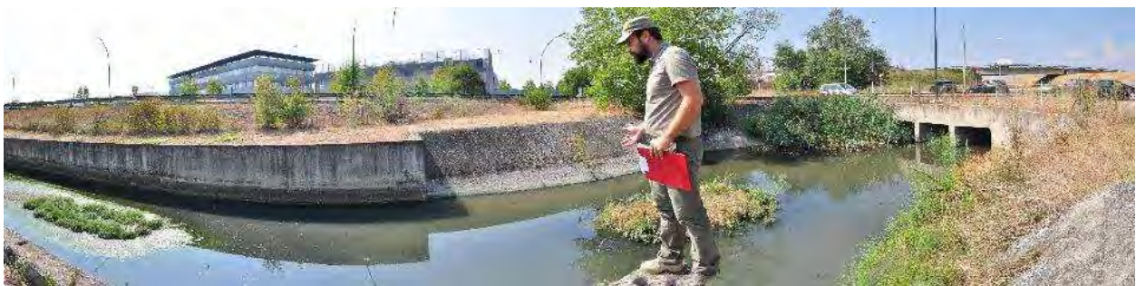
Sito ASUP-8 – Canale Colatore Sinistro, ripreso dall'argine E, prima dello scolaro sotto via del Cantone (in secondo piano).
