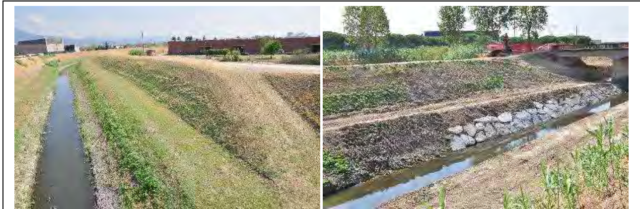
Sito ASUP-11 – Dettaglio della sezione analizzata, rispettivamente a monte (sinistra) e valle (destra). A sinistra: in evidenza i segni di ripulitura delle sponde, effettuata con mezzi meccanici. A destra: l'aspetto dell'asta fluviale in direzione di Campi Bisenzio: in evidenza i lavori per la realizzazione di una scogliera artificiale a protezione del cavalcavia soprastante (a destra in secondo piano).
