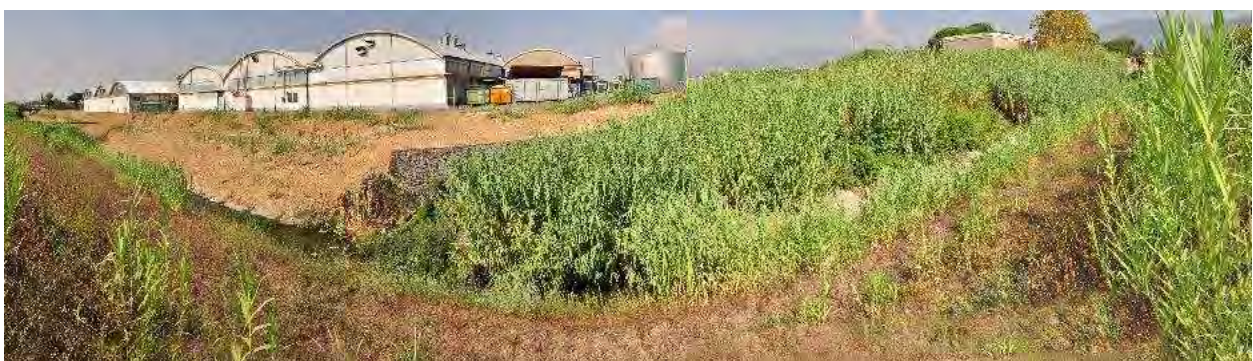
Sito ASUP-5/1 – Panoramica del sito di rilievo verso monte, a valle della confluenza con il torrente Zambra.
