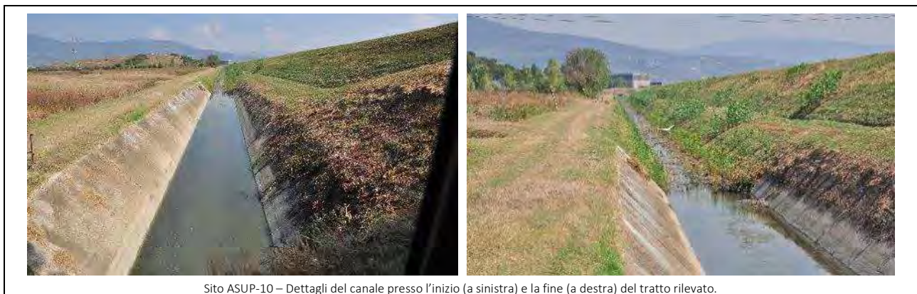
Sito ASUP-10 – Dettagli del canale presso l'inizio (a sinistra) e la fine (a destra) del tratto rilevato.
