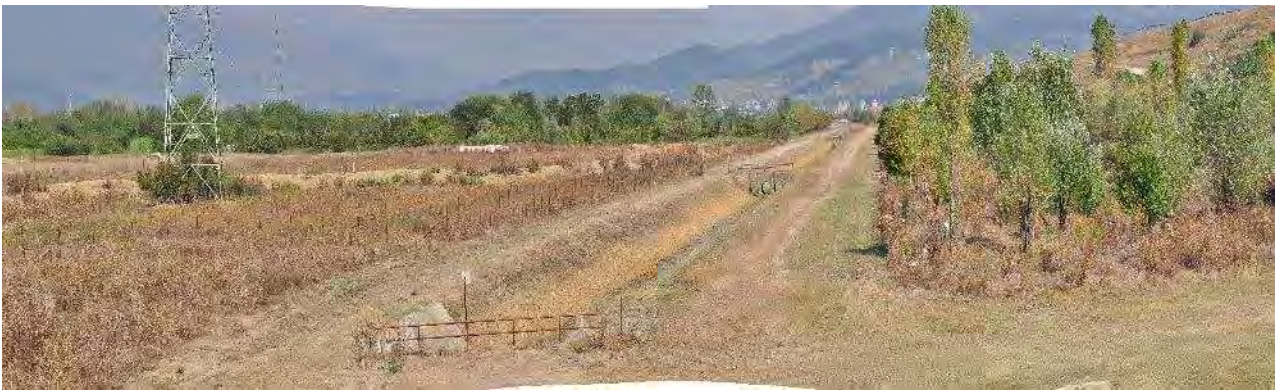
Gora dell’Acqualunga, ripreso dalla via alzaia in sponda sinistra (lato discarica di Case Passerini); sulla destra è presente un’area umida artificiale.
