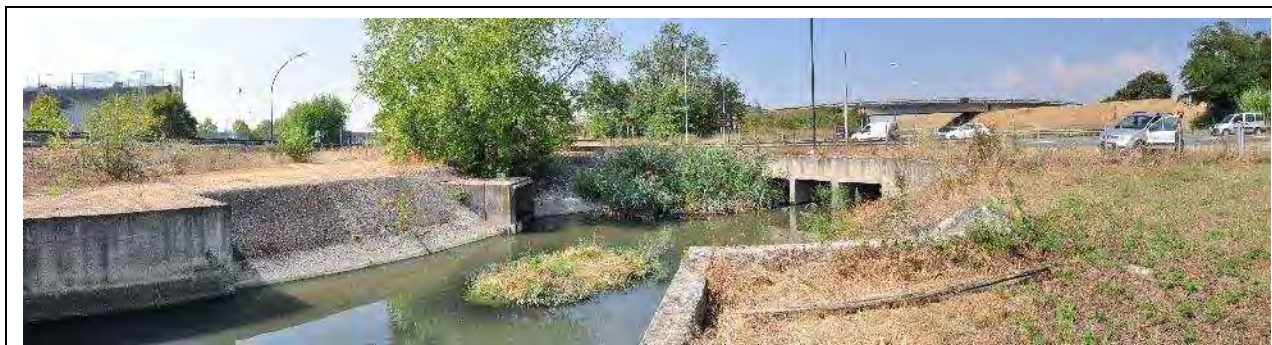
Sito ASUP-8/1 – Panoramica del sito di rilievo verso valle: si nota l'aspetto completamente artificializzato dell'alveo.
