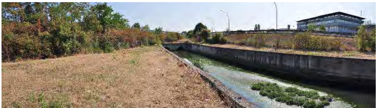
Stato del territorio circostante (domanda 1): panoramica del tratto considerato: a sud del canale (sponda sinistra, a destra nella foto) è presente un'estesa area urbanizzata; a nord del canale (a sinistra nella foto) si rilevano il tracciato autostradale ed edifici annessi a parcelle agricole.
