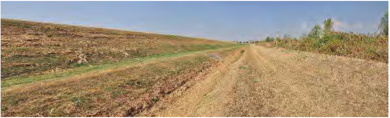
ASUP-9 – Dettagli della sezione dell'alveo presso il punto di fine del transetto: si nota la vegetazione recentemente sottoposta a sfalcio.
