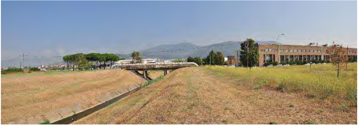
Vegetazione perifluviale (domande 2-4): aspetto del tratto a valle dell'attraversamento del gasdotto presso il Polo Scientifico di Sesto (sulla destra): la vegetazione spondale appare oggetto di opera di ripulitura e sfalcio periodico.
