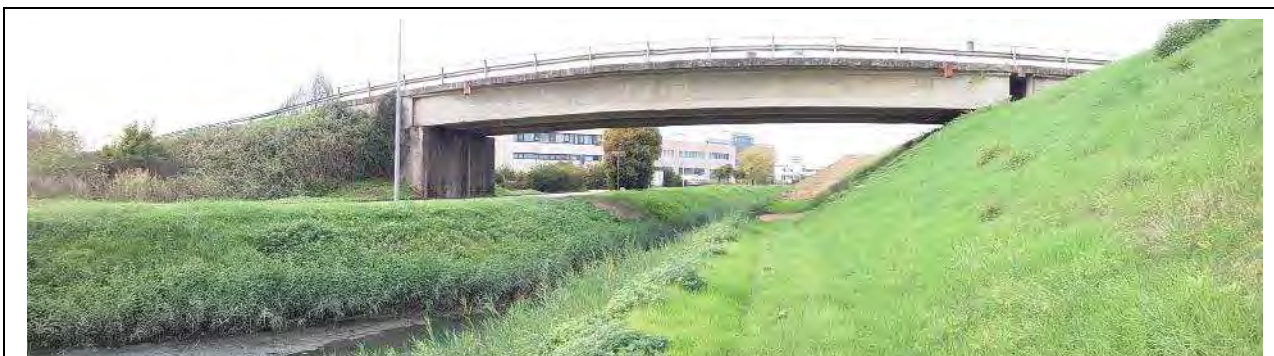
Canale Colatore Sinistro, ripreso a valle dell'attraversamento carrabile di via del Cantone; sulla sinistra si sviluppano gli edifici del complesso commerciale dell'Osmannoro; l'argine visibile sulla destra è quello del Fosso Reale.
