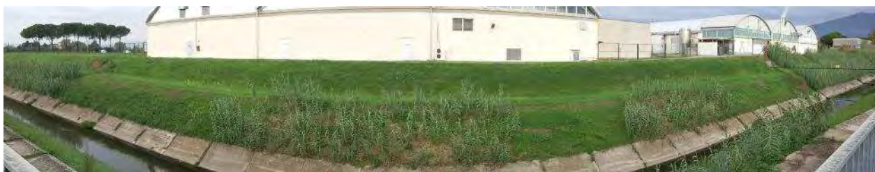
Stato dell'alveo (domande 5-9): Panoramica del tratto a valle della confluenza con il torrente Zambra; si nota la completa artificializzazione dell'alveo e la mancanza di elementi morfologici distinti.
