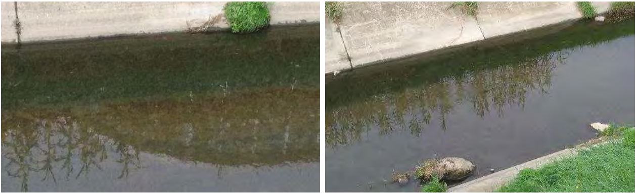
Componenti vegetali in alveo bagnato (domanda 12). Particolare dello spesso strato di perifiton presente in alveo (a sinistra), in particolare sul fondo in cemento ed attorno agli oggetti sommersi (a destra).
