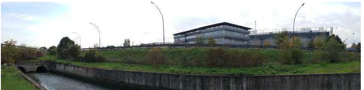
Stato del territorio circostante ( domanda 1 ): panoramica del tratto considerato: a sud del canale (sponda sinistra, a destra nella foto) è presente un'estesa area urbanizzata; a nord del canale (a sinistra nella foto) si rilevano il tracciato autostradale ed edifici annessi a parcelle agricole.
