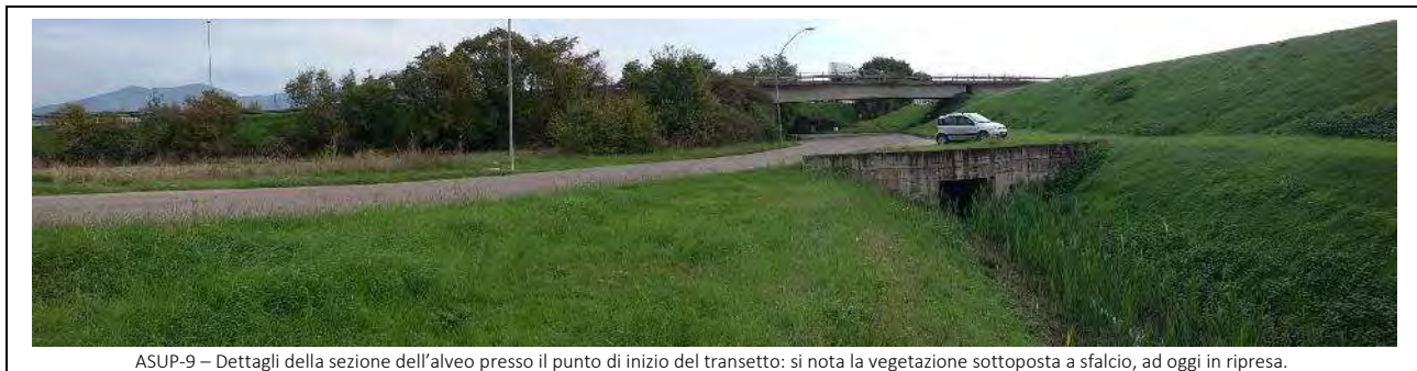
ASUP-9 – Dettagli della sezione dell'alveo presso il punto di inizio del transetto: si nota la vegetazione sottoposta a sfalcio, ad oggi in ripresa.
