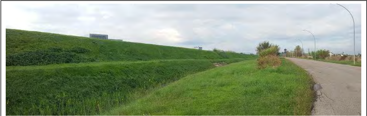
Canale Colatore Destro, ripreso dall'attraversamento pedonale presso via del Pantano.
