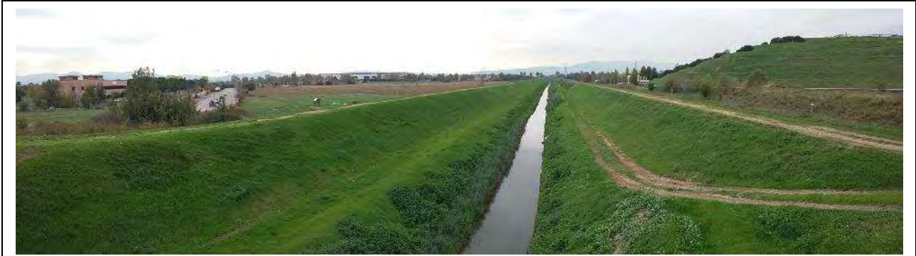
Sito ASUP-11 – Panoramica dell'aspetto del canale presso l'inizio del transetto di rilevamento: sulla destra, il profilo della discarica in via di rinaturalizzazione.
