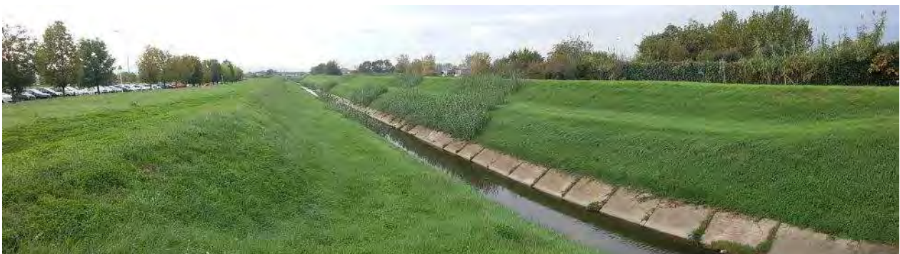
Sito ASUP-5 – Torrente Rimaggio (a monte della confluenza nel Fosso Reale); in secondo piano, a sinistra, si notano alcune pertinenze del Polo Scientifico di via Detti.
