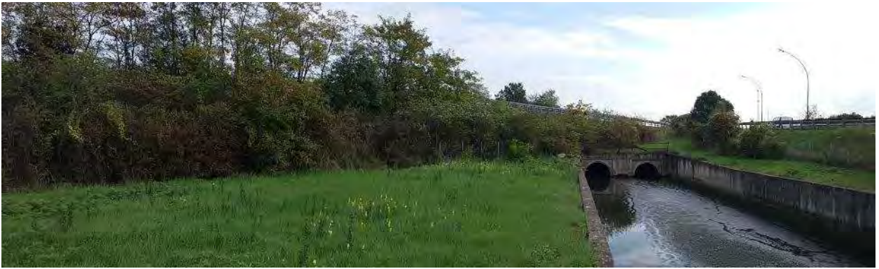
Sito ASUP-8/1 – Panoramica del sito di rilievo verso monte: si nota la scarsa vegetazione perfluviale e lo stato dell'alveo.
