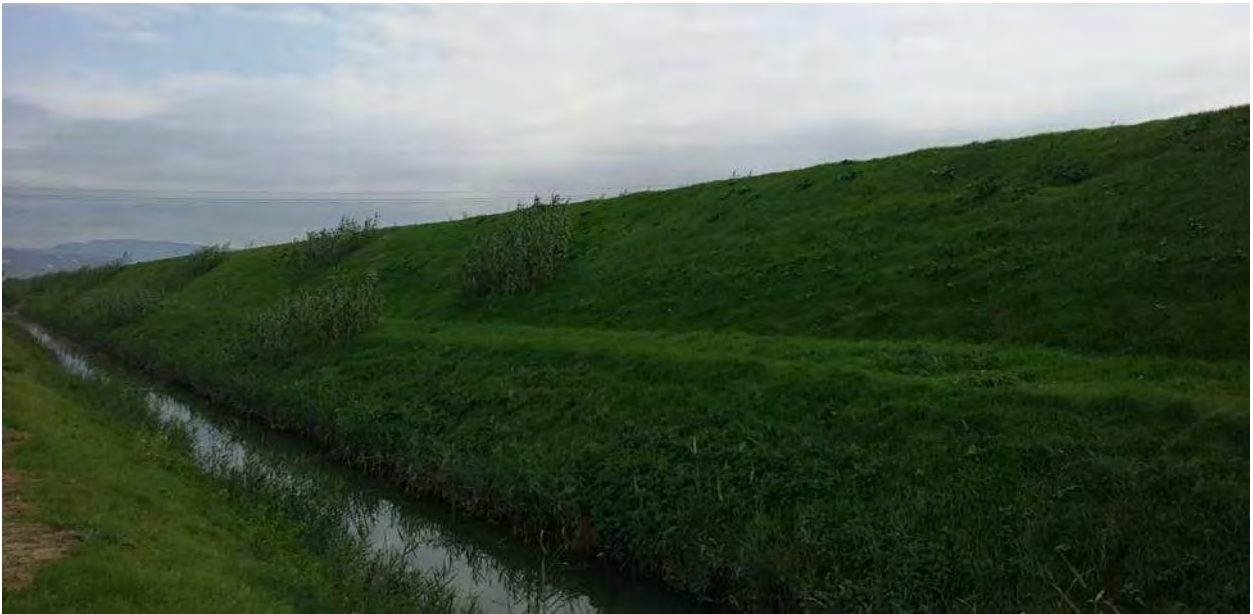
Stato dell'alveo (domande 5-9). Sezione dell'alveo completamente artificializzata presso il termine del transetto di rilievo, priva di vegetazione spondale. Tutte le sezioni considerate presentano scarsa diversità morfologica dovuta all'origine artificiale del canale in esame.
