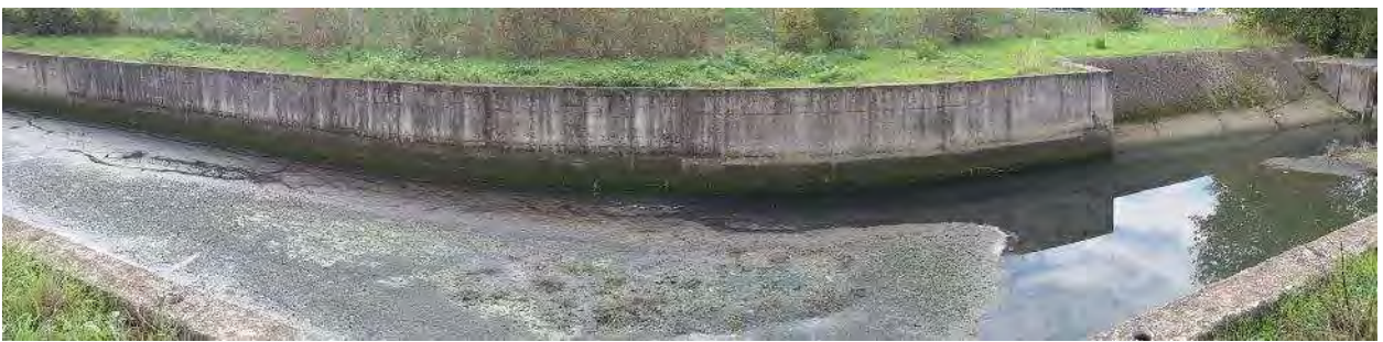
Canale Colatore Sinistro, ripreso nell'area interclusa da infrastrutture viarie (A11, via del Cantone) in loc. Osmannoro.
