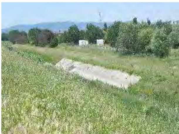
**Stato dell'alveo** (domande 5-9). A sinistra: sezione dell'alveo completamente artificializzata al centro del transetto di rilievo, priva di vegetazione spondale. A destra: sezione artificializzata presso il termine del transetto. Tutte le sezioni considerate presentano scarsa diversità morfologica dovuta all'origine artificiale del canale in esame.
