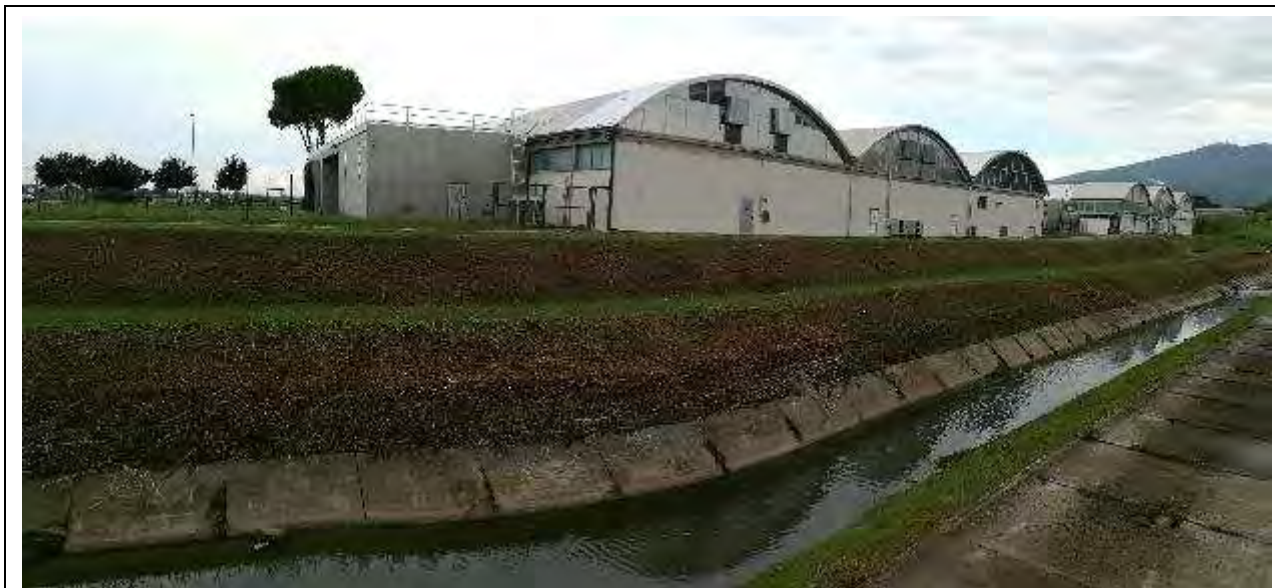
Sito ASUP-5/1 – Panoramica del sito di rilievo verso monte, a valle della confluenza con il torrente Zambra; sono visibili gli annessi industriali presenti in sponda destra.
