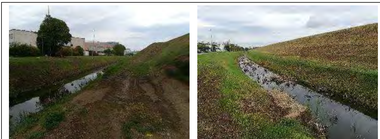
Stato del territorio circostante (domanda 1). Aspetto del canale lungo il tratto considerato: A sinistra: in sponda sinistra è presente un'estesa area urbanizzata (Osmannoro, in secondo piano). S destra: a monte della sponda destra, ad eccezione delle infrastrutture stradali (autostrada A11) e del Fosso Reale (il cui argine è visibile sulla destra), l'area è prevalentemente occupata da parcelle agricole.
