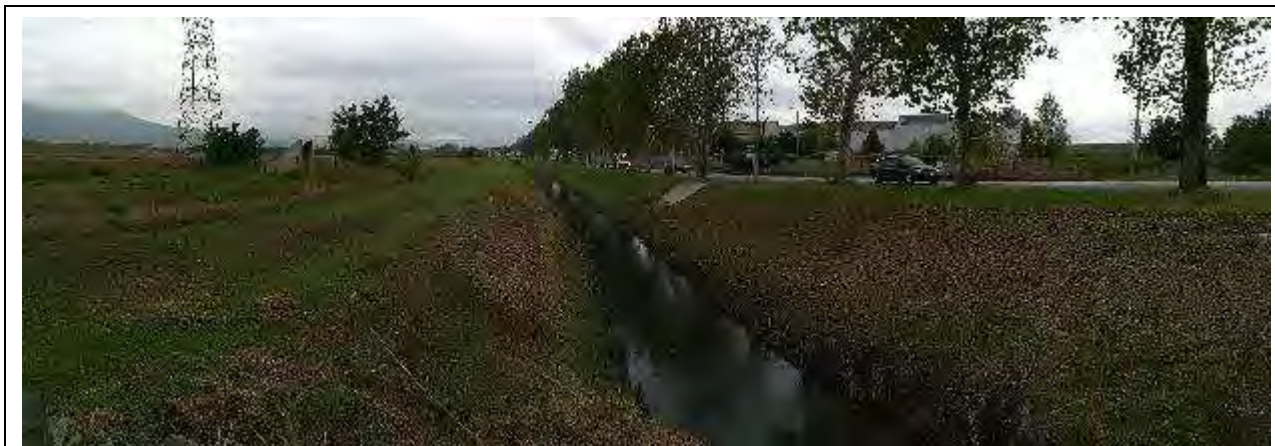
Fosso Osmannoro, tratto a valle dell'attraversamento pedonale accessibile da via Lucchese.
