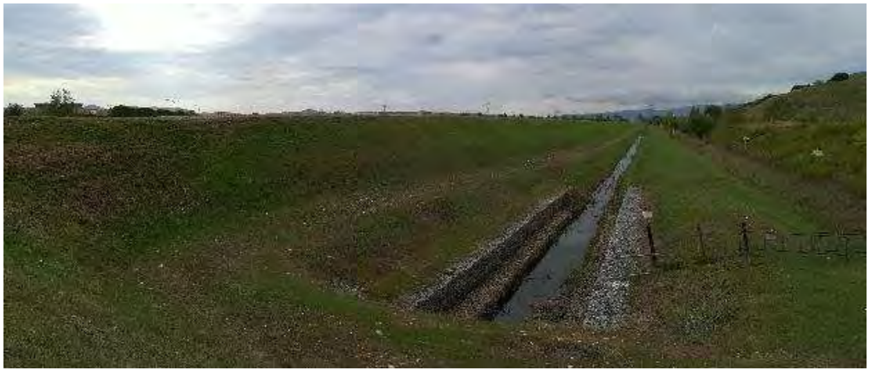
Sito ASUP-10 – Aspetto del canale presso l'inizio del tratto rilevato.
