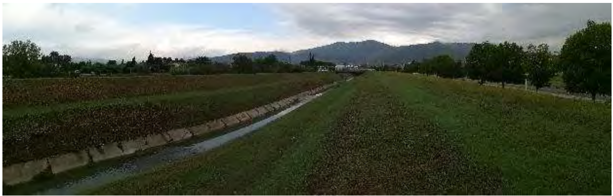
Sito ASUP-5 – Torrente Rimaggio (a monte della confluenza nel Fosso Reale); a destra, dietro gli alberi, si intravedono alcune pertinenze del Polo Scientifico di via Detti.
