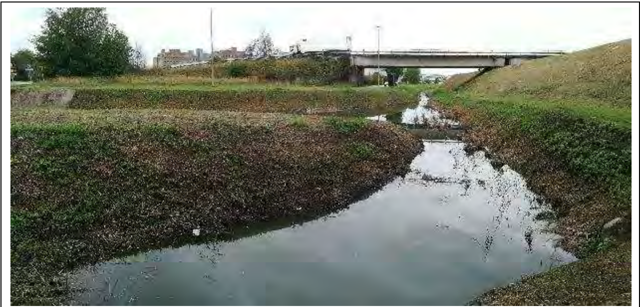
Sito ASUP-8/2 – Panoramica del sito di rilievo a valle rispetto all'attraversamento di via del Cantone.
