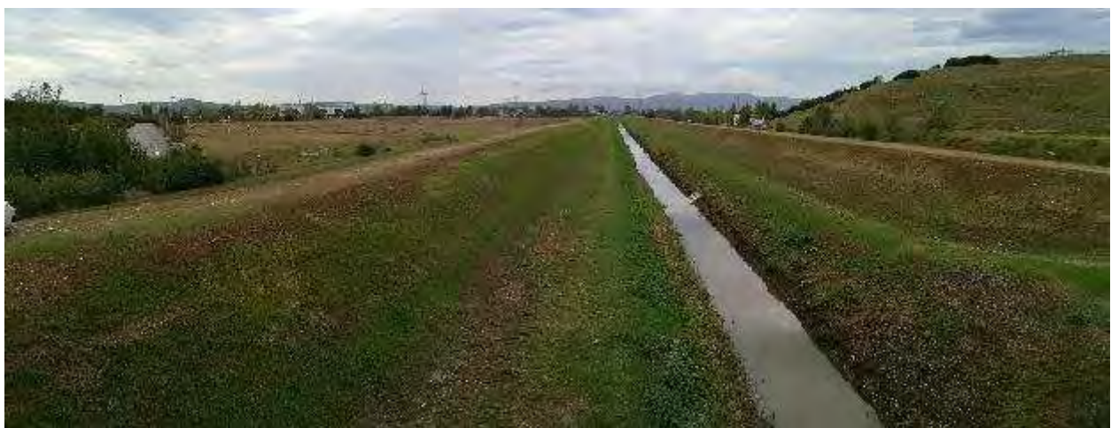
Sito ASUP-11 – La sezione monitorata del Fosso Reale, fiancheggiata rispettivamente dai canali Colatore Destro (ASUP-10) e Sinistro (non monitorato per il tratto in esame). In secondo piano, sulla destra, è visibile il profilo della discarica in loc. Case Passerini.
