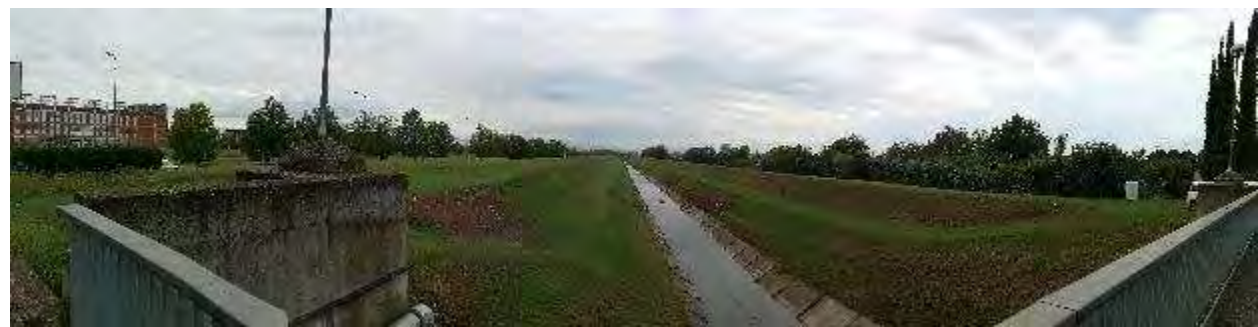
Stato del territorio circostante (domanda 1). Panoramica verso valle: sono visibili gli edifici del Polo Scientifico che si affacciano su via Detti.
