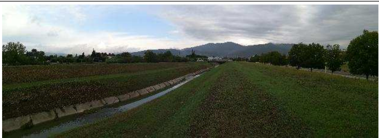
Torrente Rimaggio, tratto a valle dell'attraversamento carrabile di viale delle Idee.
