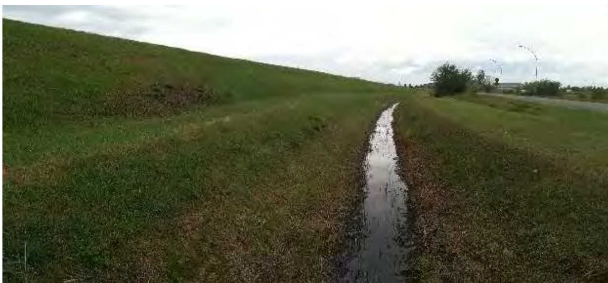
Canale Colatore Destro, ripreso dal punto di inizio del transetto.
