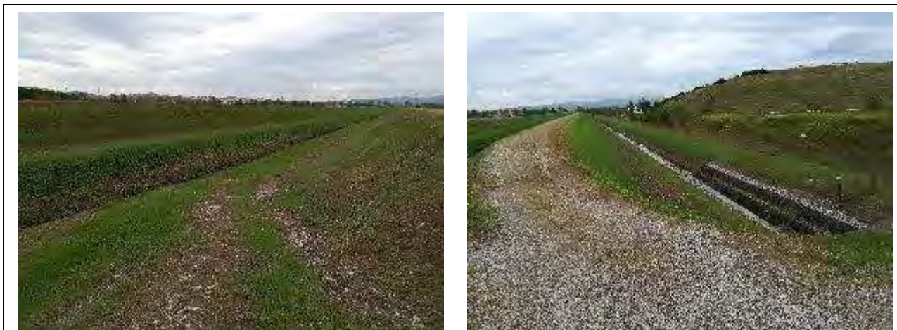
Stato del territorio circostante (domanda 1): A sinistra: la sponda sinistra è contermina ad alcune aree agricole, a loro volta seguite dagli edifici industriali e del terziario dell'Osmannoro (in secondo piano). A destra: la sponda destra è caratterizzata da aree naturali (chiarì per acquatici) e impianti industriali (inceneritore della discarica di Case Passerini).
