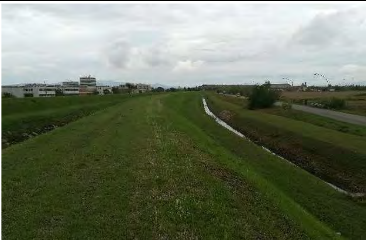
ASUP-9 – Panoramica del territorio che circonda il tracciato del corso d'acqua, ripreso dalla via di alzaia contermina al canale Colatore Destro (ASUP-10).
