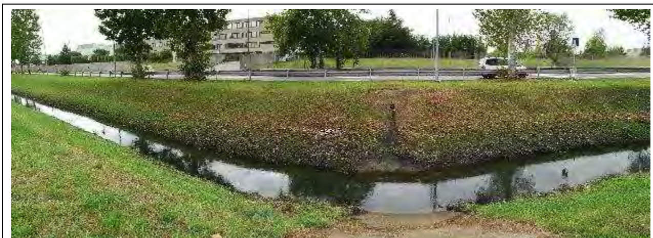
Sito ASUP-12 – Panoramica dell'aspetto della sponda destra, in secondo piano, il tracciato di via Lucchese.
