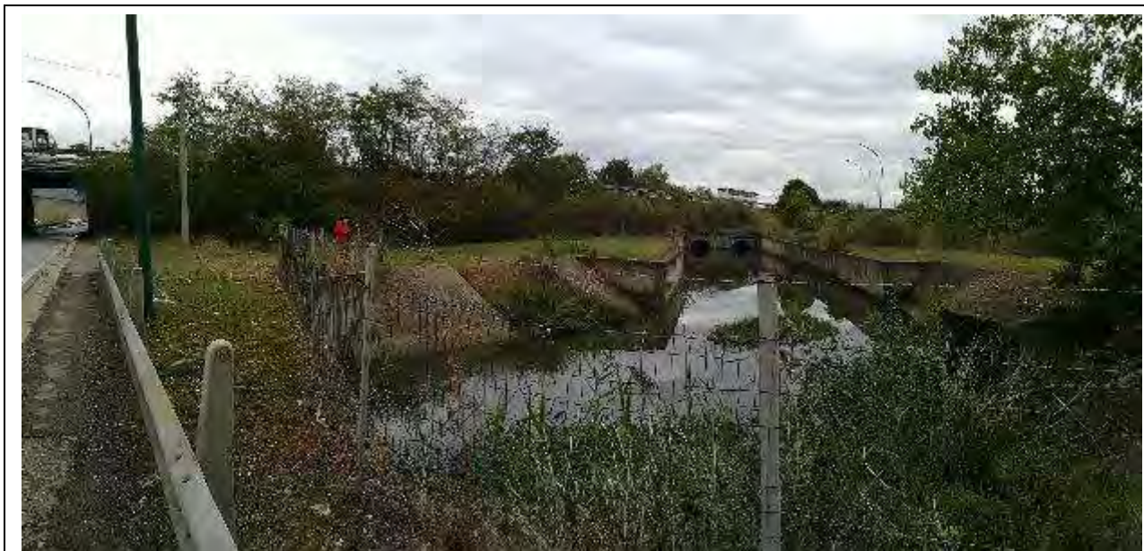
Sito ASUP-8/1 – Panoramica del sito di rilievo verso monte: si nota l'aspetto completamente artificializzato dell'alveo.
