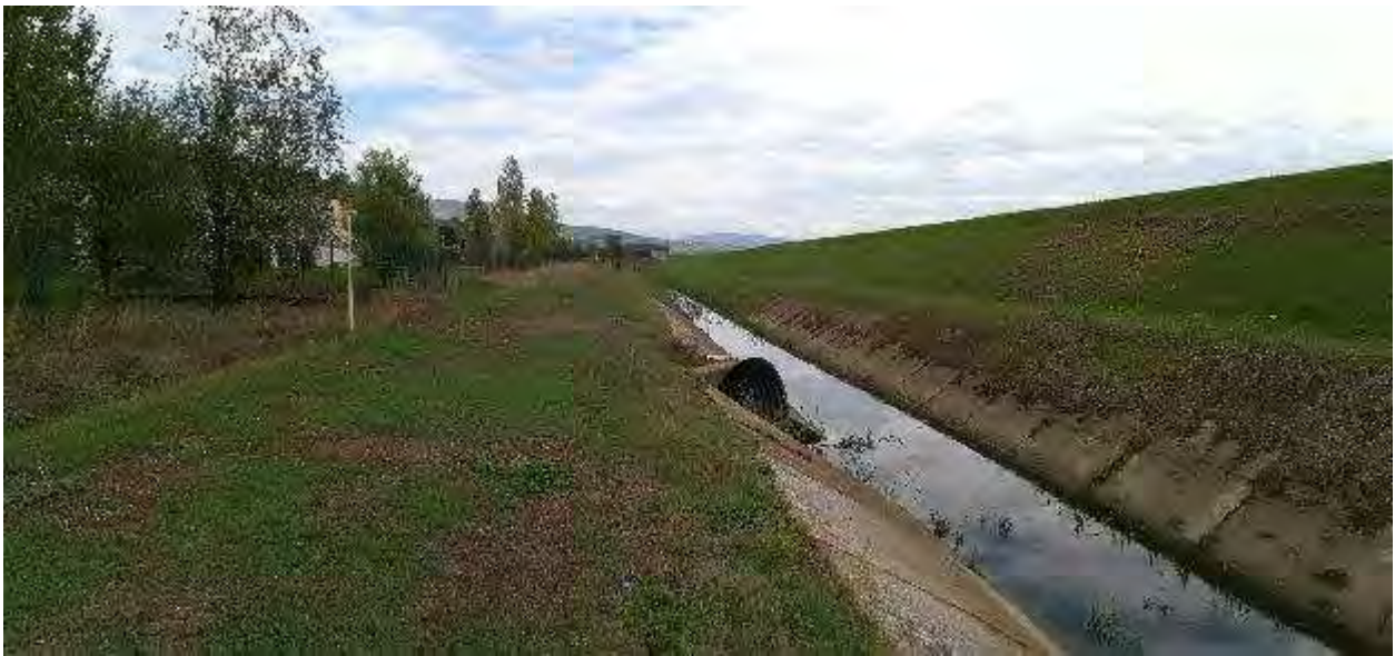
Stato dell'alveo (domande 5-9). La sezione dell'alveo completamente artificializzata al centro del transetto di rilievo, priva di vegetazione spondale. Tutte le sezioni considerate presentano scarsa diversità morfologica dovuta all'origine artificiale del canale in esame.
