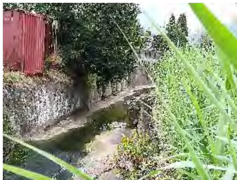
Stato dell'alveo (domande 5-9). A sinistra: la struttura verticale delle sponde rende virtualmente inesistente la capacità di esondazione. A destra: la sezione appare priva di elementi morfologici strutturati per la maggior parte del tratto considerato, nonostante alcuni tentativi di sinuosità riscontrati nella parte più a monte del transetto.
