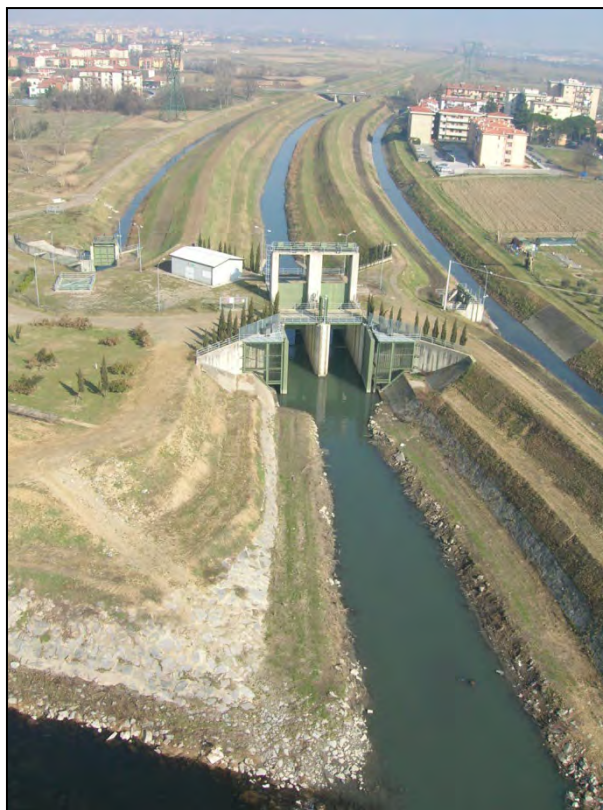
Figura 5. vista delle porte Vinciane- vista da valle.
