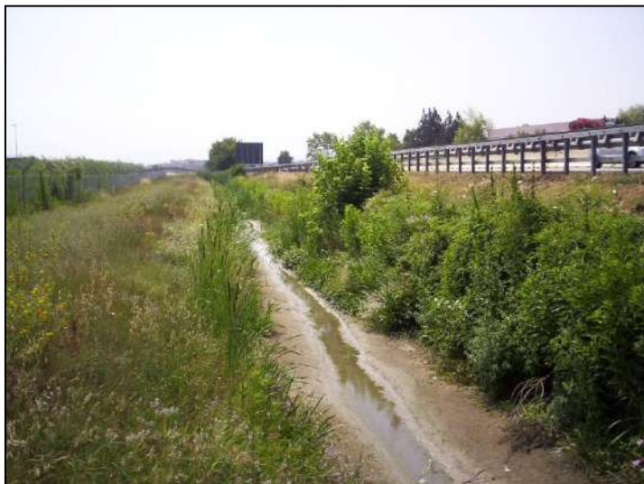
Figura 23. Vista del canale dell'Aeroporto.
