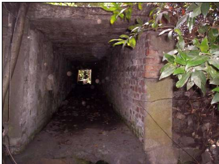
Figura 24. Vista della sezione scatolare del 1° tratto del canale dell'Aeroporto.
