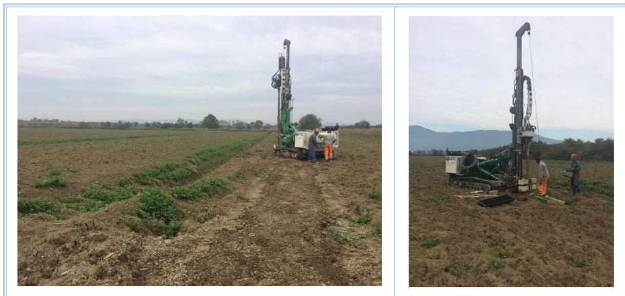
Figura 18: Fase di realizzazione dei piezometri.
