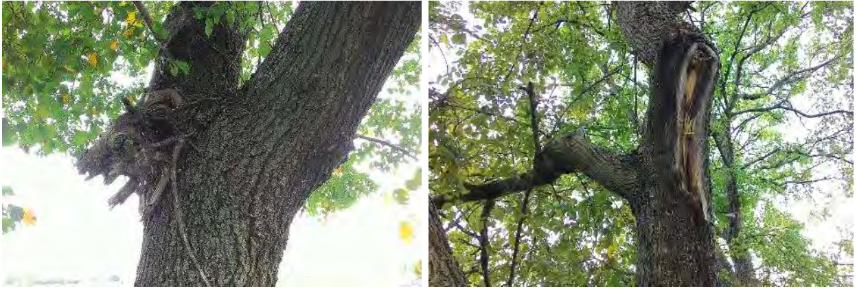
IP01 – dettaglio vegetazionale. A sinistra: rami stroncati, verosimilmente con mezzi meccanici. A destra: profonda scosciatura sulla parte alta del corno, probabilmente in conseguenza di eventi meteorici. Tali danneggiamenti giustificano la classe di danno attribuita (lieve).
