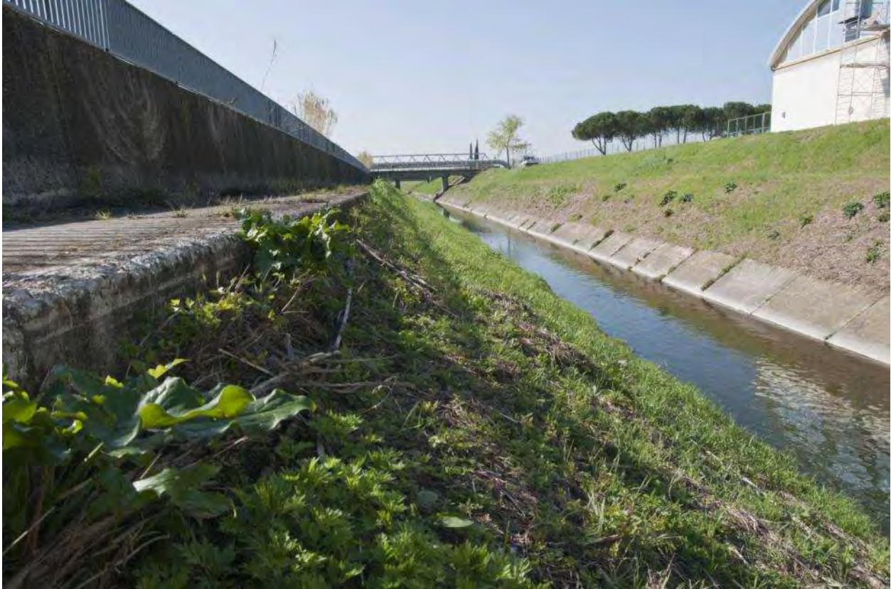
Figura 2.23: Torrente Rimaggio: vegetazione su sponda sinistra idrografica.
