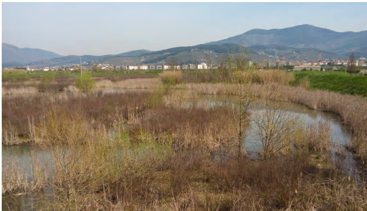
Figura 7 - Cassa di espansione
