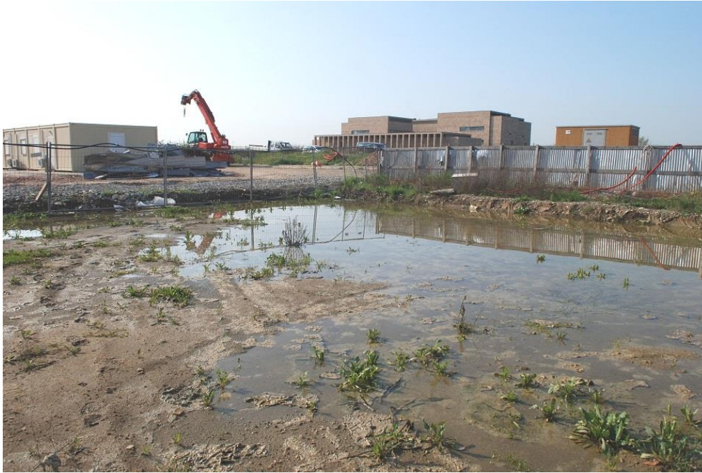
Fig. 28: Una delle aree di cantiere del Polo Scientifico Universitario di Sesto Fiorentino in via di cantierizzazione (nei pressi dell'edificio detto 'Incubatore') ove sono stati tratti in salvo centinaia e centinaia di individui di tutte le cinque specie di Anfibi presenti nella zona dalle squadre di volontari del WWF (per gentile concessione dell'Archivio WWF – Foto C. Scoccianti – Anno 2010)
