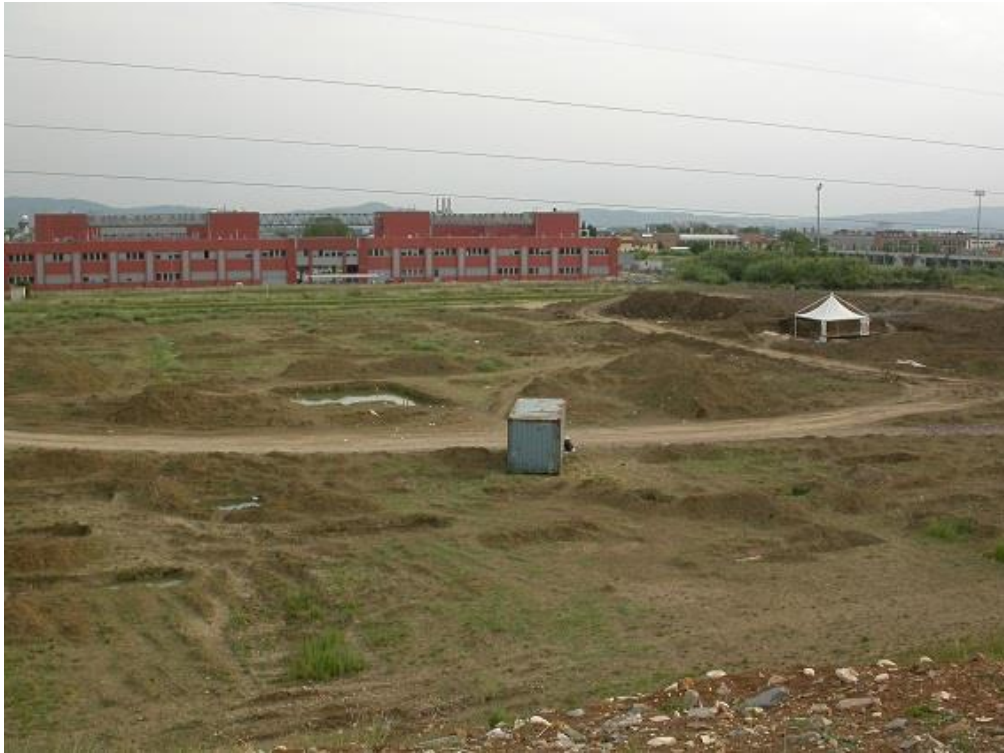
Fig. 27: Una delle aree di cantiere del Polo Scientifico Universitario di Sesto Fiorentino in via di cantierizzazione (nei pressi dell'edificio del CNR) ove sono stati tratti in salvo centinaia e centinaia di individui di tutte le cinque specie di Anfibi presenti nella zona dalle squadre di volontari del WWF (per gentile concessione dell'Archivio WWF – Foto C. Scoccianti – Anno 2005)
