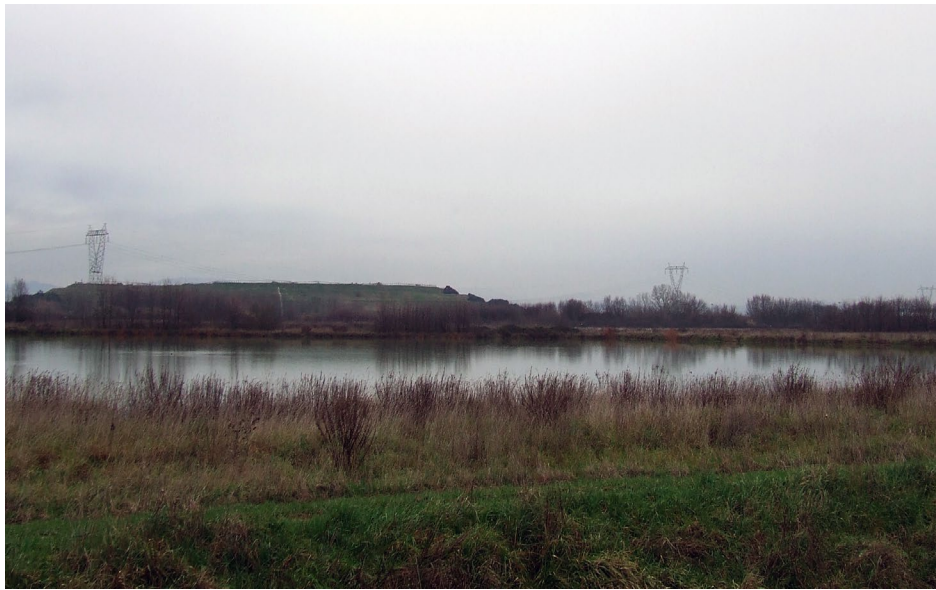
Fig. 2.6 - Cassa di espansione di Focognano
