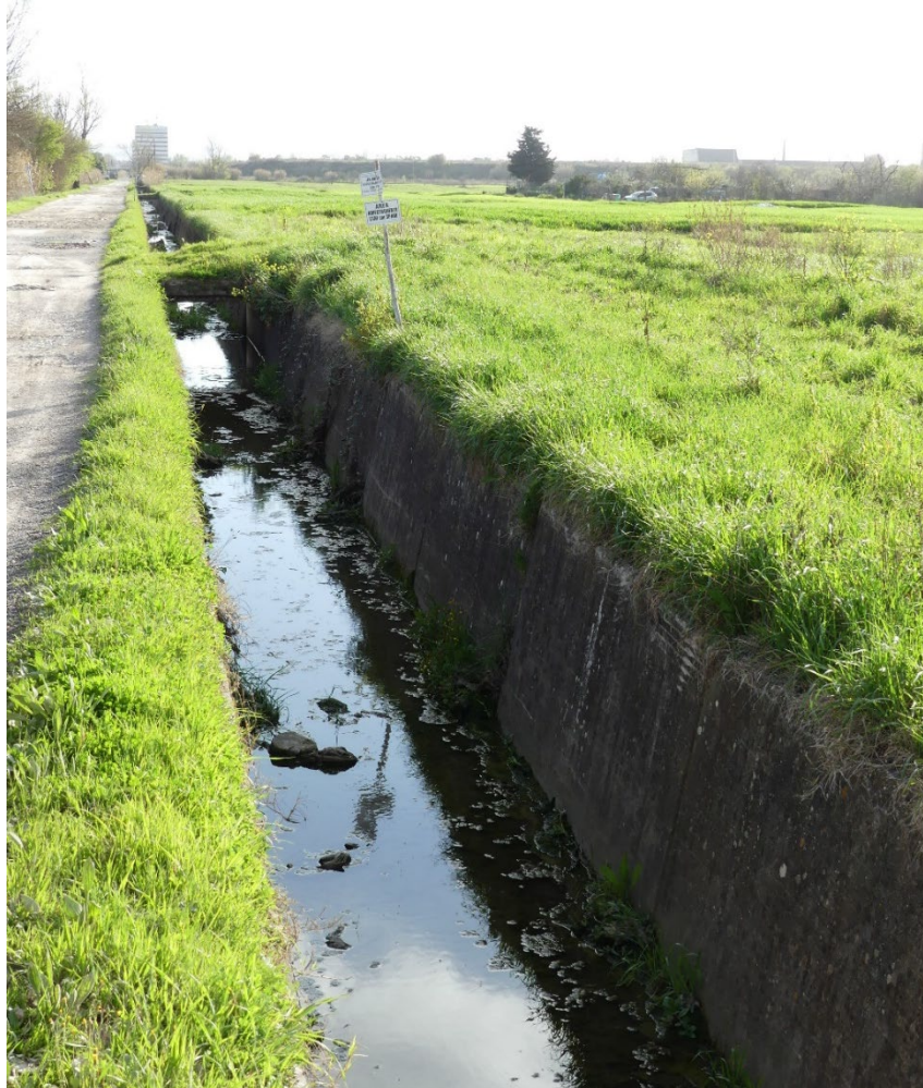
Figura 33 - Area di studio denominata "Zona 4" ove è stato effettuato il Monitoraggio degli Anfibi e dei Rettili durante il periodo 2016-2018: è mostrato un tratto del canale in cemento con pareti verticali presente sul lato est lungo via di Gavine. Esso rappresenta un fortissimo fattore negativo di impatto sulle specie: gli individui infatti vi possono cadere all'interno senza poi poter più uscire. (foto C. Scoccianti, 16 marzo 2023)
