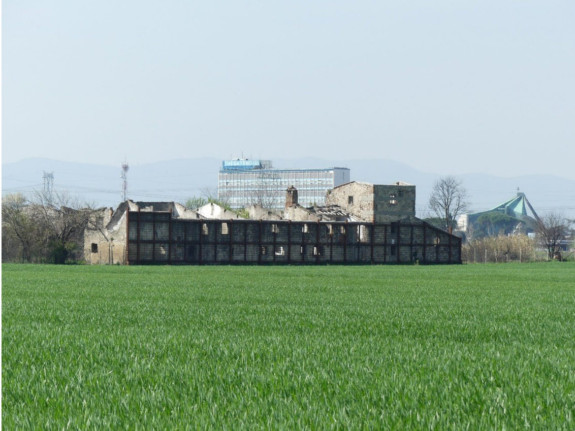
Figura 44 - Area di studio denominata “Zona BD03” ove è stato effettuato il Monitoraggio dei Chiroterteri durante il periodo 2017-2018: è mostrata un’immagine dell’edificio abbandonato presente nell’area.
