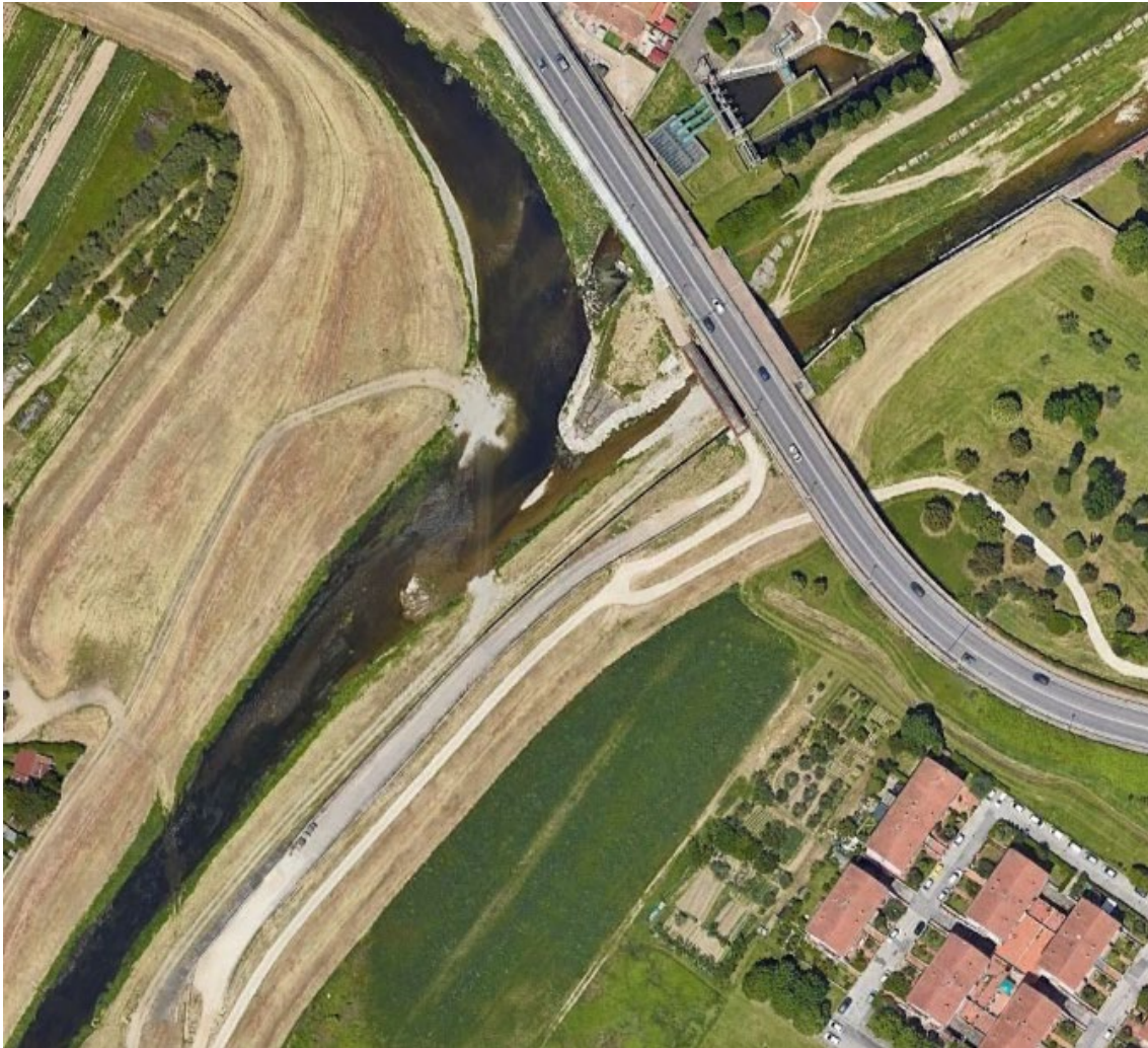
Figura 49 - Area di studio denominata “Zona BD14” ove è stato effettuato il Monitoraggio dei Chiroteri durante il periodo 2017-2018: la foto satellitare indica lo status del sito nell’anno 2022, dopo la realizzazione della nuova passerella ciclo-pedonale (in affiancamento, lato sud, al preesistente ponte della Circonvallazione Nord – freccia rossa) che permette il passaggio della nuova pista ciclabile sopra al torrente Marina. (fonte: Google Earth – data indicata 11 maggio 2022)
