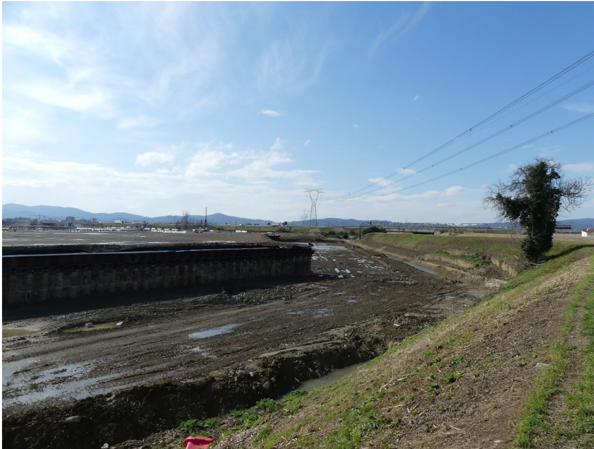
Figura 11 - Porzione a sud dell'Area di studio n. 6 ove è stato effettuato il Monitoraggio dell'avifauna durante il periodo 2015-2020); è mostrata una immagine della zona ove è in corso d'opera la realizzazione una cassa di espansione lineare destinata a ospitare al proprio interno un habitat a prato umido - acquitrino. (foto C. Scoccianti, 2 marzo 2023)
