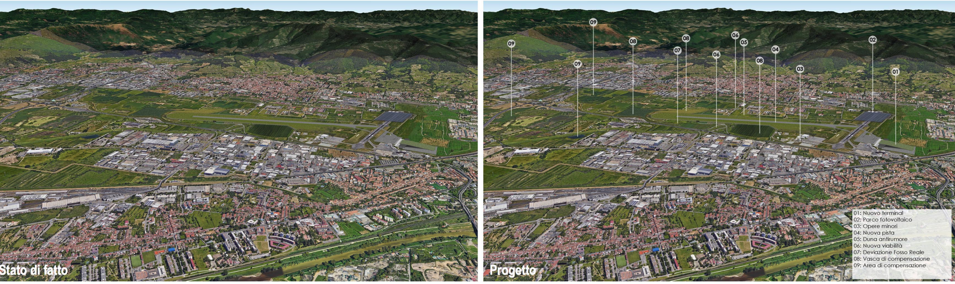
1 Veduta aerea generale da sud-ovest dell'area di intervento - Fotoinserimento delle opere dello scalo aeroportuale e opere di compensazione
