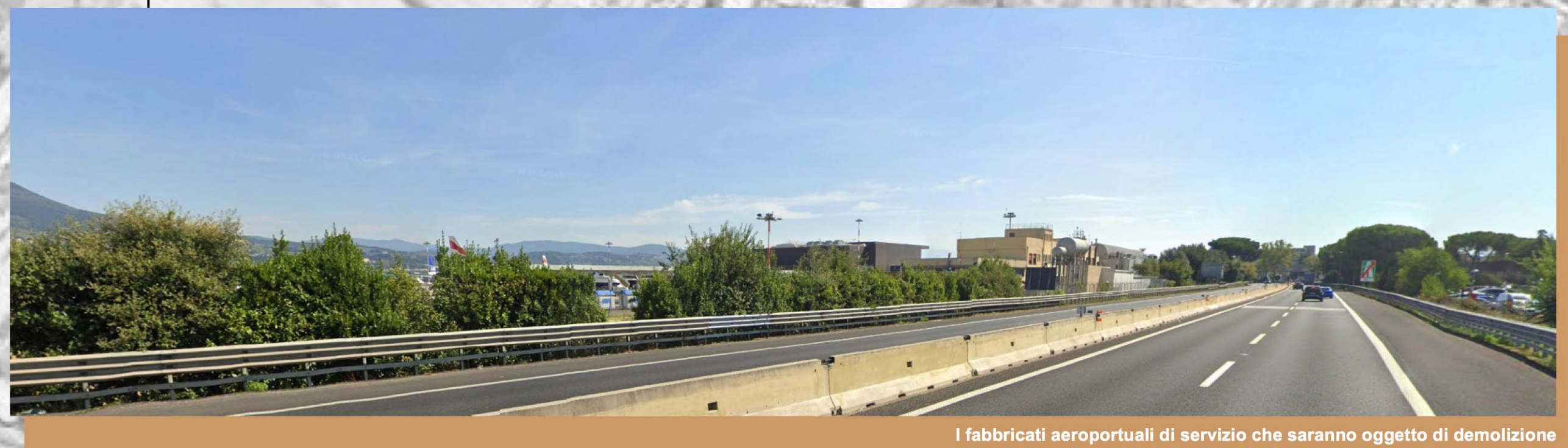
I fabbricati aeroportuali di servizio che saranno oggetto di demolizione
