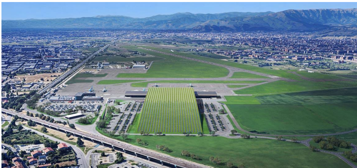
Figura 3-2: - Vista della nuova aerostazione
