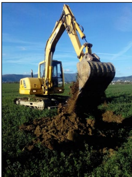
Figura 3-1: Fase di realizzazione dei sondaggi
