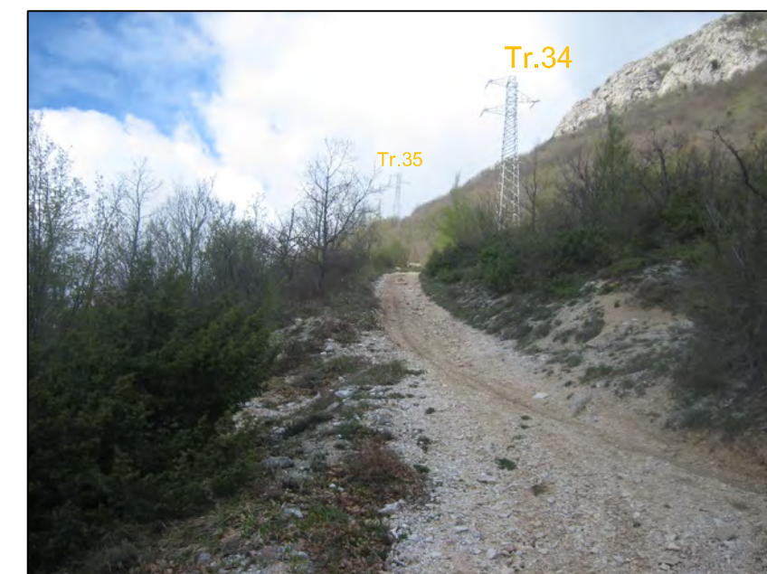
Foto 53 Pista d'arrocamento al Tr.34
